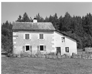
Façade antérieure de la maison de douaniers. Phot. Jérôme Mongreville IVR43_19943900807X
