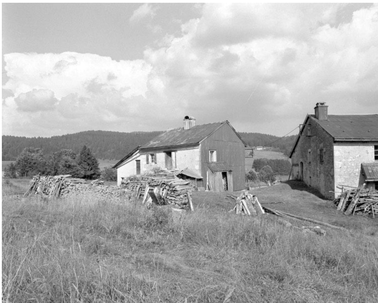
Façade postérieure et face gauche de la maison de douaniers, recouvertes d'un essentage de tôle.
