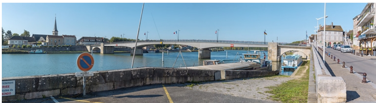
Vue d'ensemble depuis Saint-Jean-de-Losne, rive droite.
