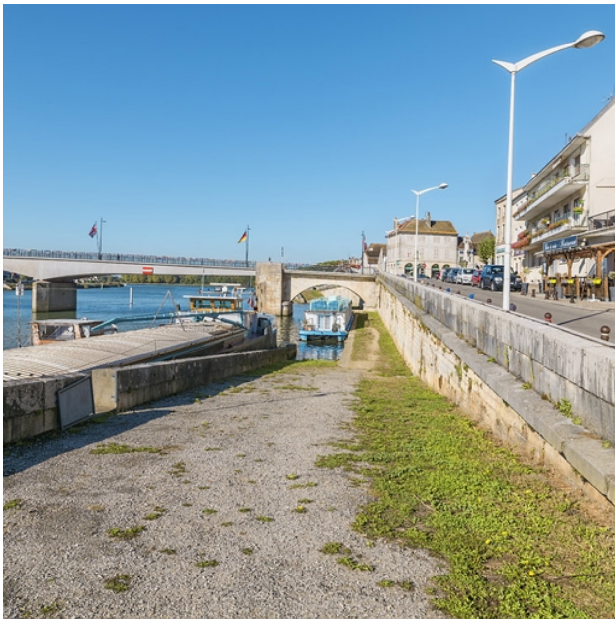
Arche maçonnée du pont, rive droite.
