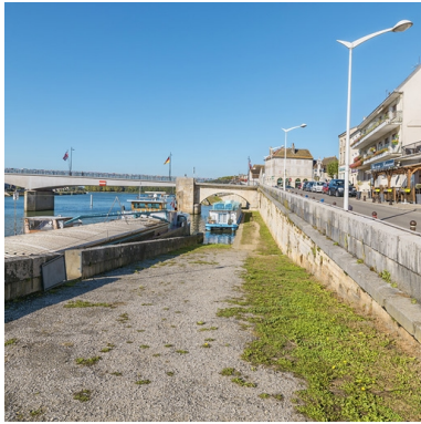
Arche maçonnée du pont, rive droite.
