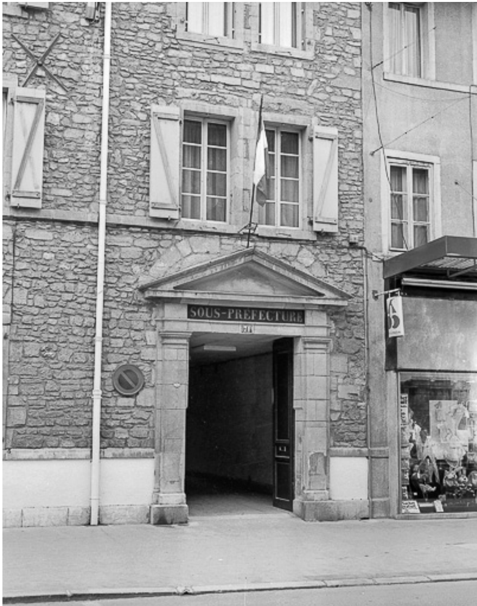
Le portail d'entrée du couvent.
