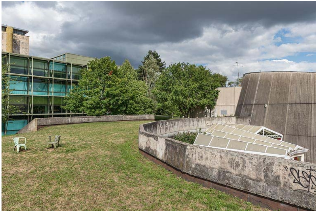
Aile semi-circulaire : toiture végétalisée.
