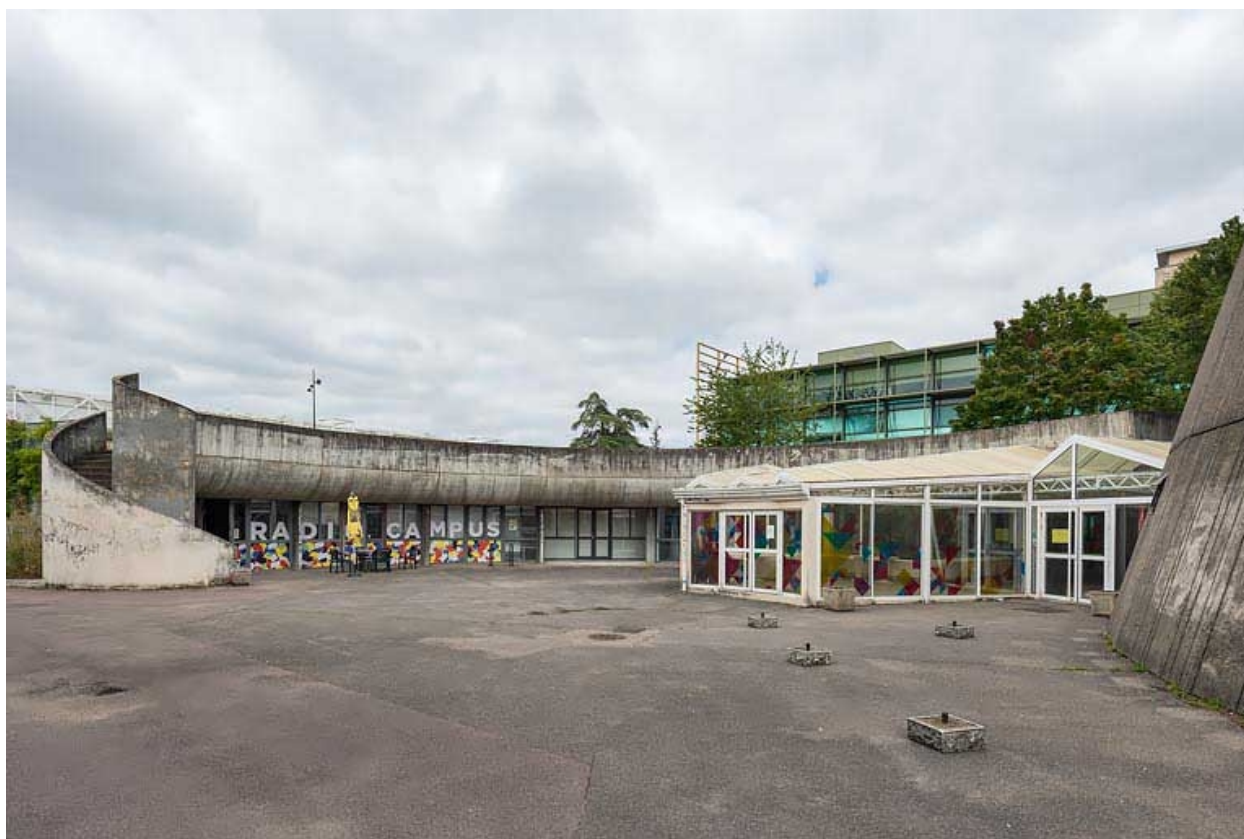
Façade sur cour.
