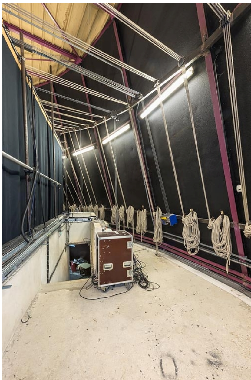
Salle : circulation latérale et charpente métallique.
