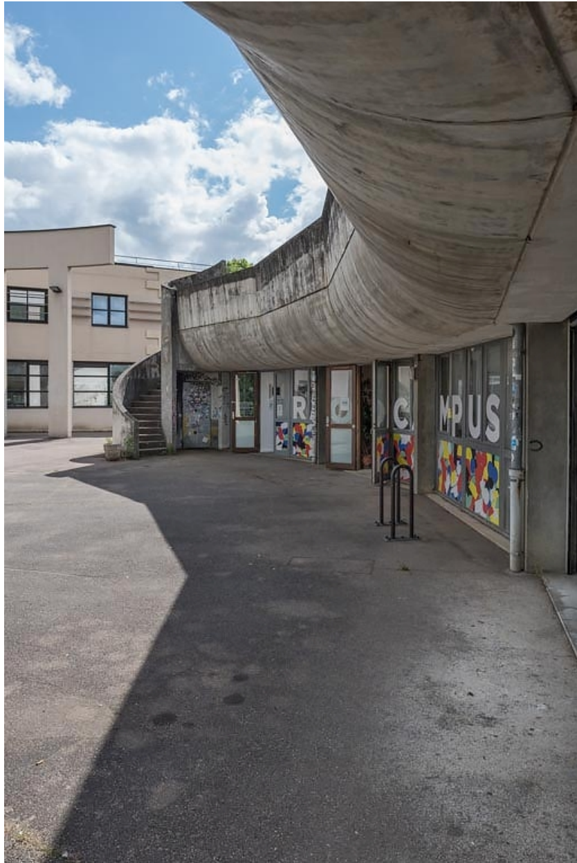
Aile semi-circulaire : toiture formant auvent côté cour.
