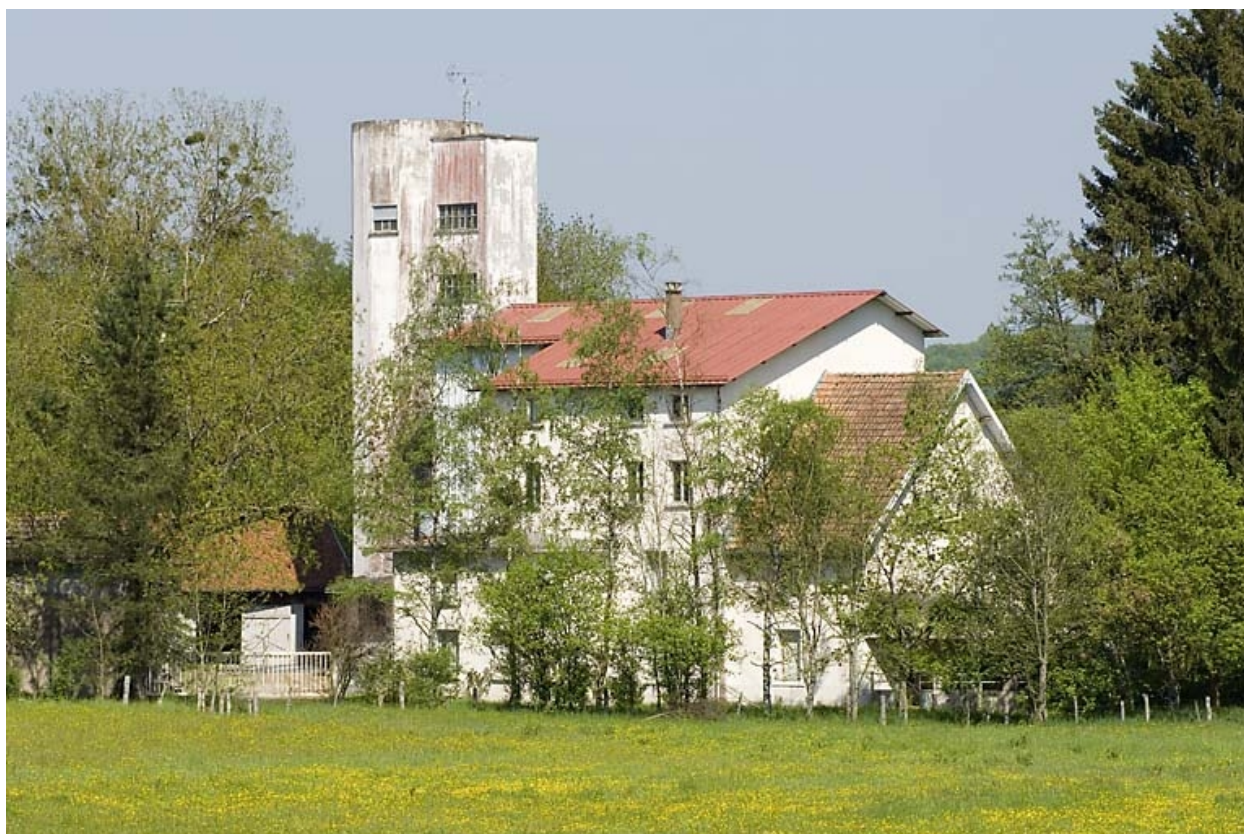
Façade occidentale vue de trois quarts.
