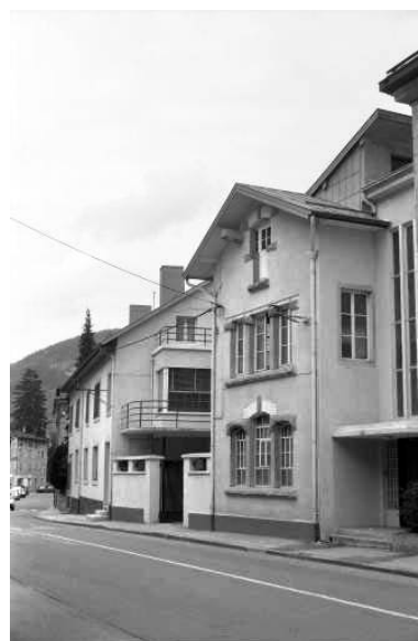
Rue de la République : vue d'ensemble. Phot. Laurent Poupard IVR43_19913901443Z
