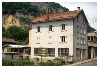
Avenue Charles de Gaulle : atelier Lamy Lunetterie. Phot. Laurent Poupard IVR43_19913901469ZA
