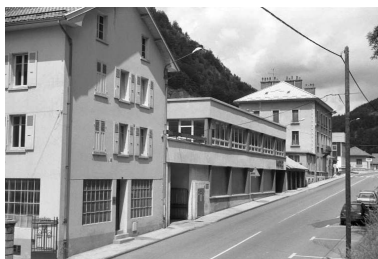
Avenue Charles de Gaulle : vue d'ensemble. Phot. Laurent Poupard IVR43_19913901471Z
