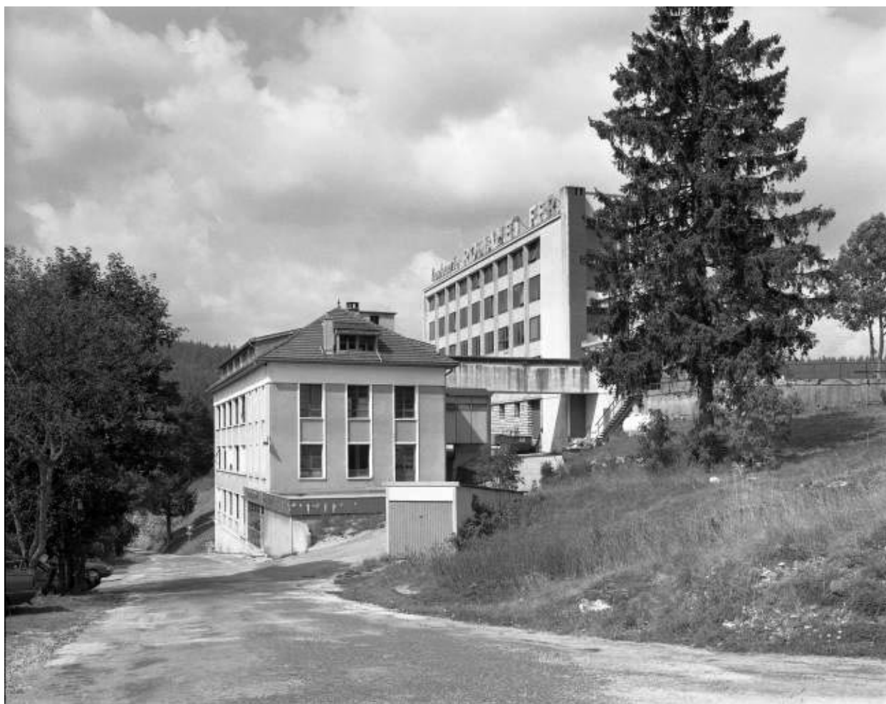
Façade latérale droite des bâtiments.
