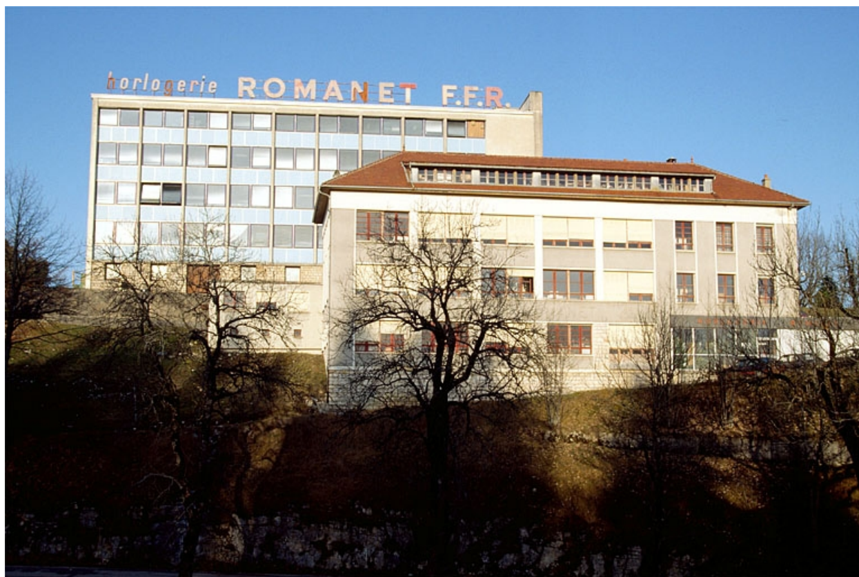
Façade antérieure des bâtiments.
