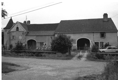
Ferme située Grande Rue. Phot. Bernard Lardière IVR43_19817000385Z
