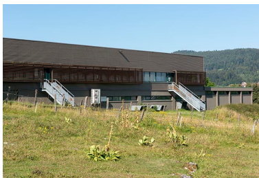
Façade postérieure : escaliers extérieurs vers l'angle nord-ouest.
