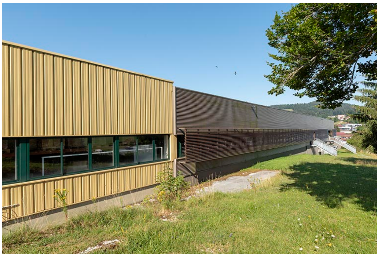
Façade postérieure, vue en enfilade.
