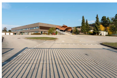
Vue d'ensemble, depuis l'entrée au sud-ouest. Phot. Sonia Dourlot IVR43_20182501586NUC4A
