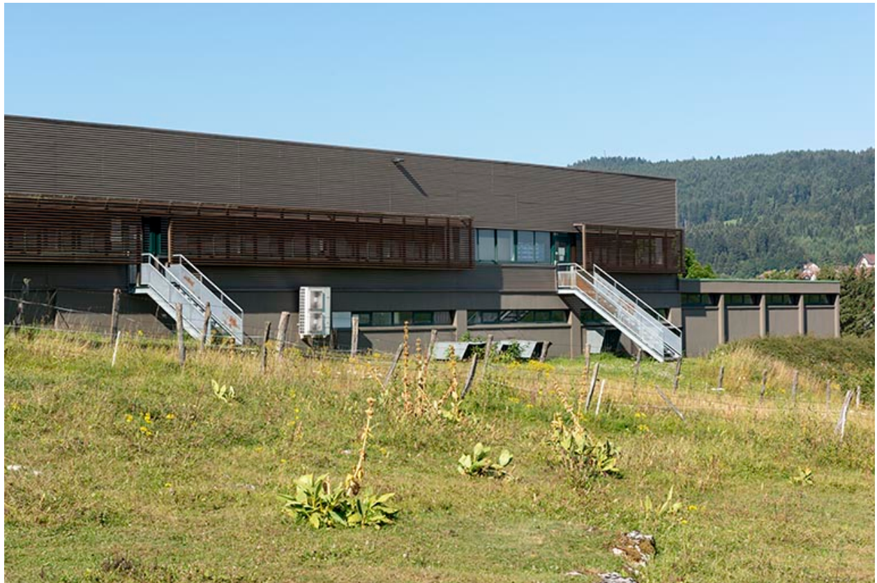
Façade postérieure : escaliers extérieurs vers l'angle nord-ouest.
