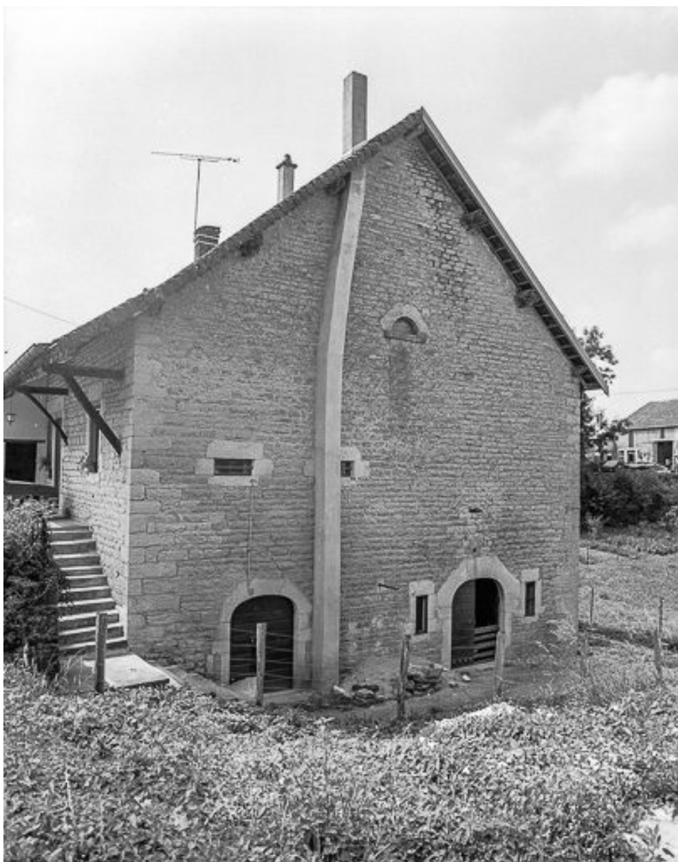
Façade latérale droite.
