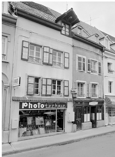
Façade sur rue. Phot. Jérôme Mongreville IVR43_19872500885X
