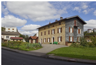
Ferme 42-44 rue Pasteur Phot. Yves Sancey IVR43_20103900462NUC2A
