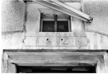
Façade sur rue. Détail de la porte. Phot. Jérôme Mongreville IVR43_19872500920X
