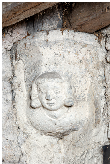
Cave du bâtiment sur rue. Culot figuré. Phot. Nicolas Waltefaugle IVR43_20253900301NUC4A
