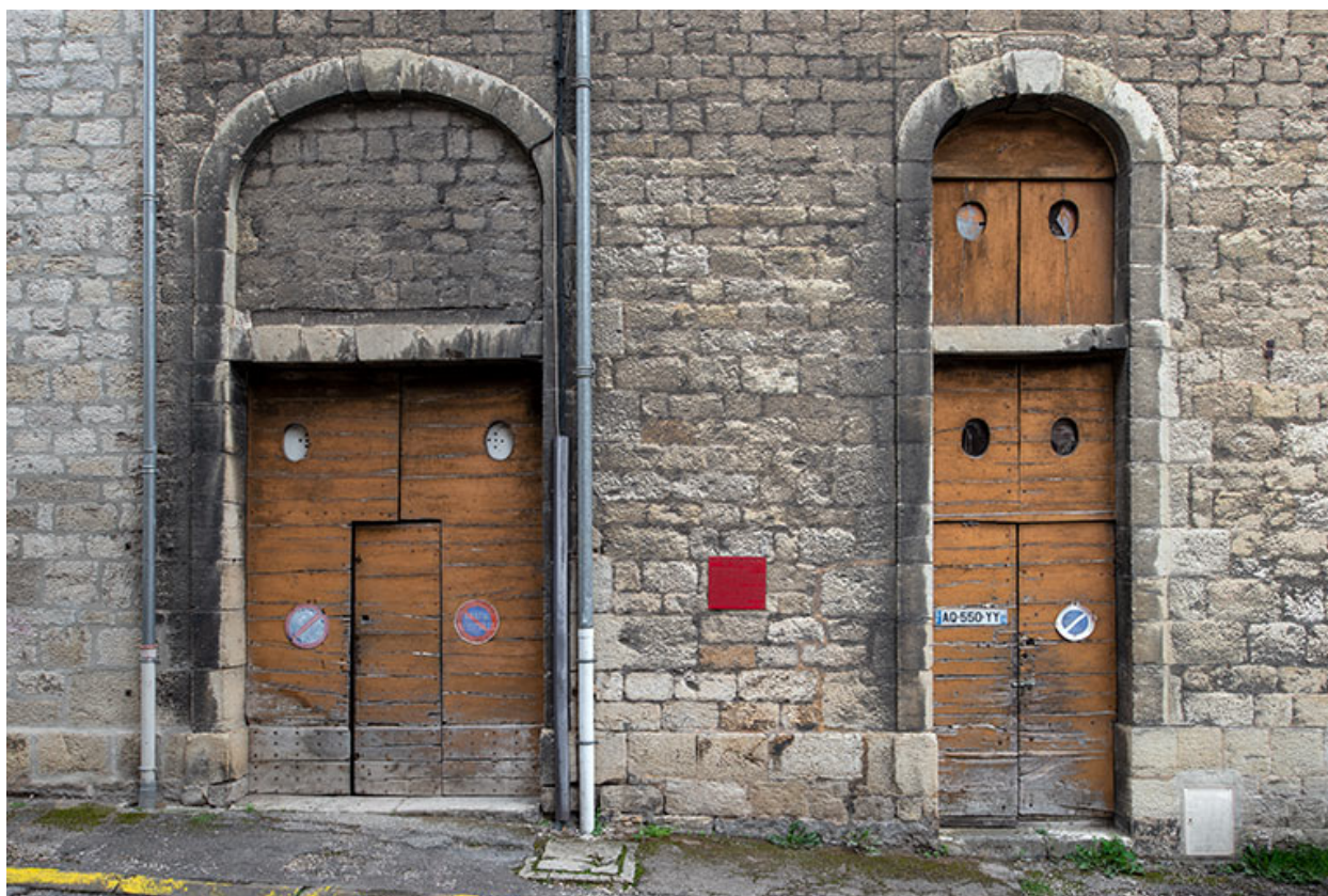
Façade sur rue. Portes des travées sud.
