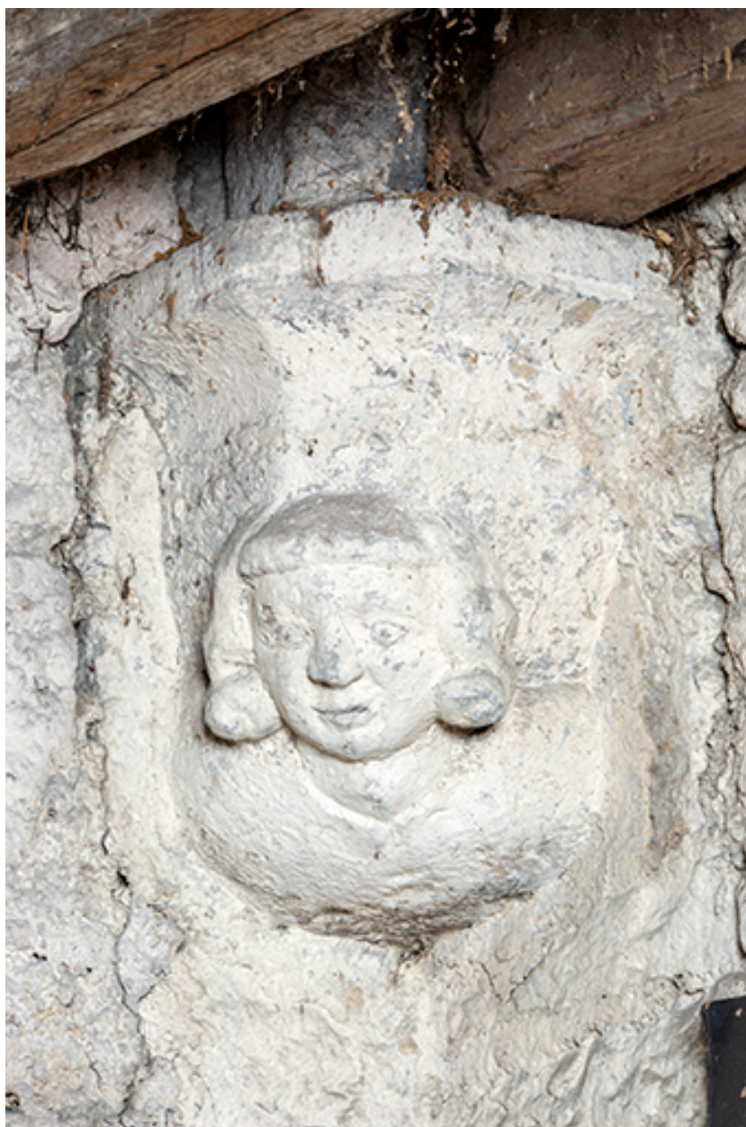
Cave du bâtiment sur rue. Culot figuré.
