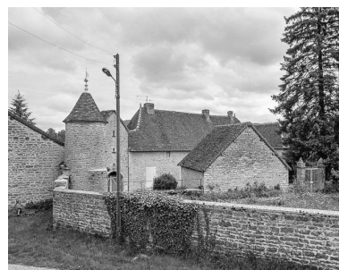
Demeure située chemin du Prélot : vue d'ensemble. Phot. Yves Sancey IVR43_19813900091X
