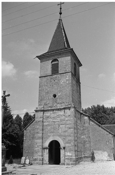
Eglise paroissiale Saint-Symphorien. Phot. Guy Forestier IVR43_19743900336Z
