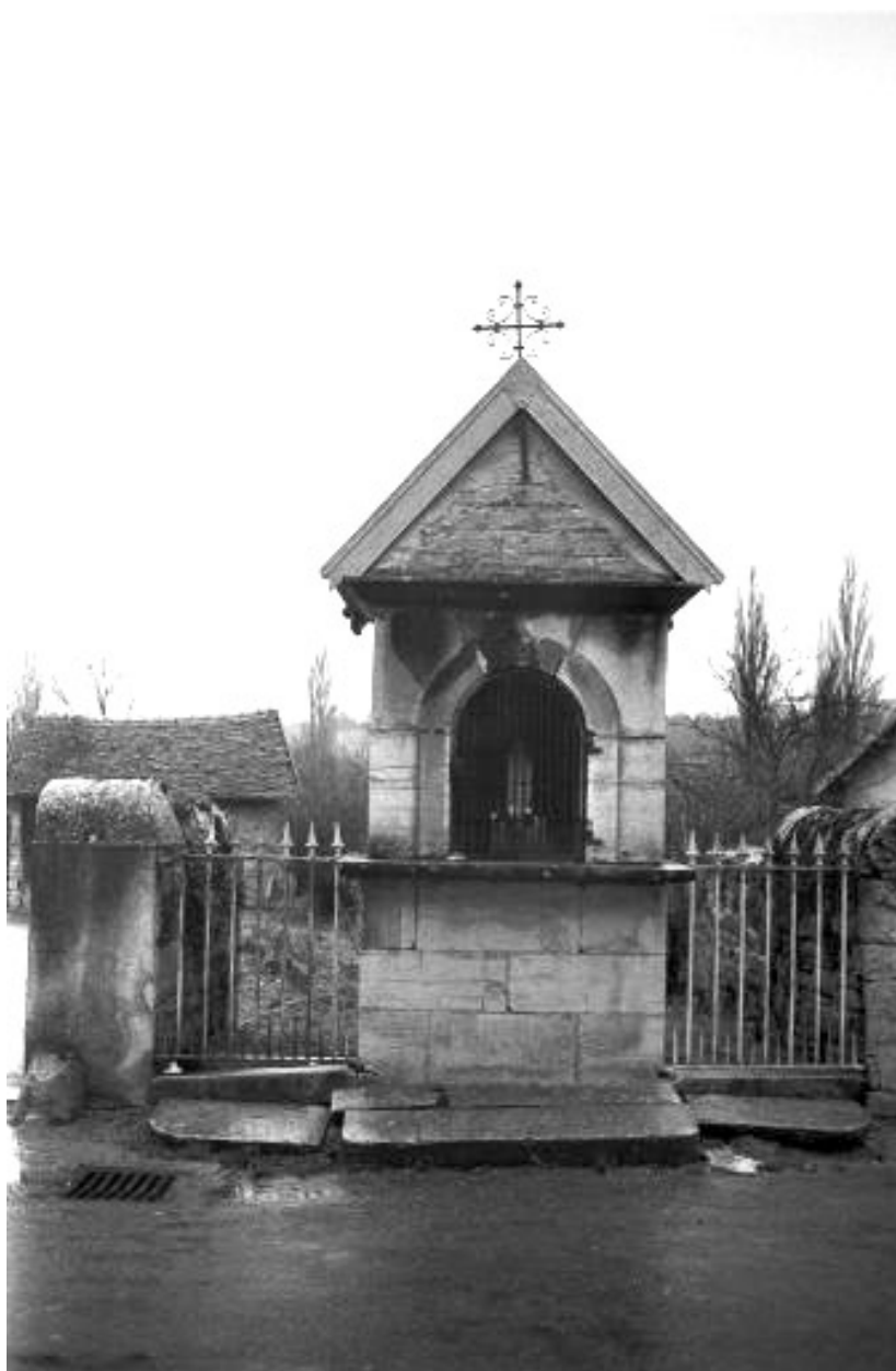
Oratoire situé à l'angle de la rue Désiré Monnier et de la rue Beaupoil.
