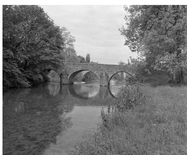
Pont de la route départementale 47. Phot. Yves Sancey IVR43_19813900073X
