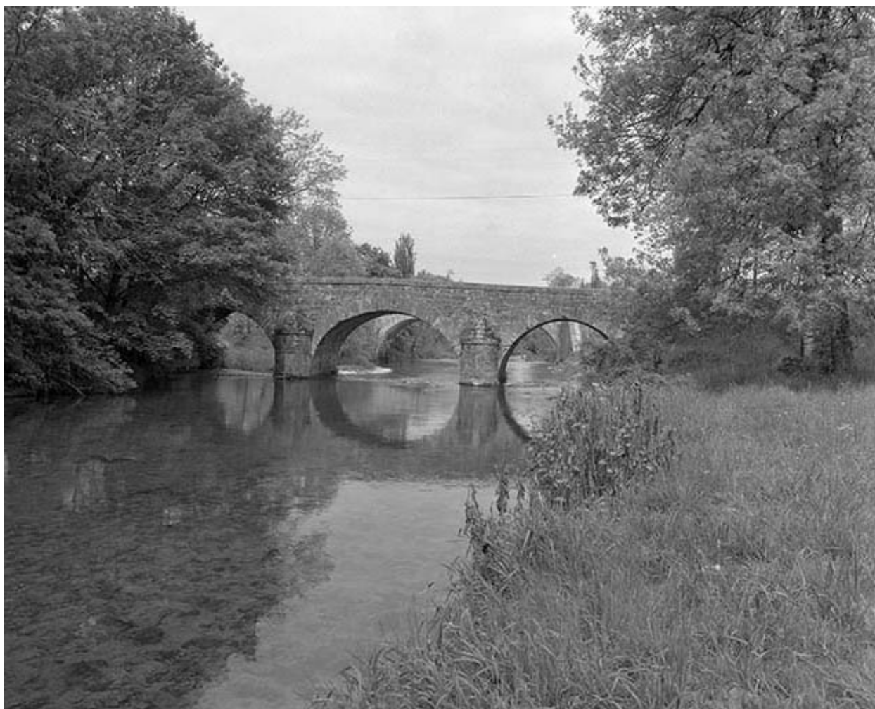
Pont de la route départementale 47.
