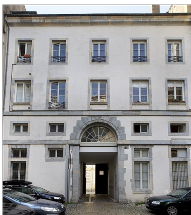
Façade postérieure, de face. Phot. Yves Sancey IVR43_20102501276NUC2A
