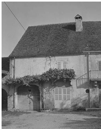
Ferme située rue de la Liberté. Phot. Dominique Dominguez IVR43_19803900021X
