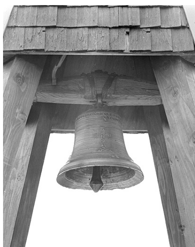
Vue depuis le nord-ouest. Phot. Yves Sancey IVR43_19963901837X
