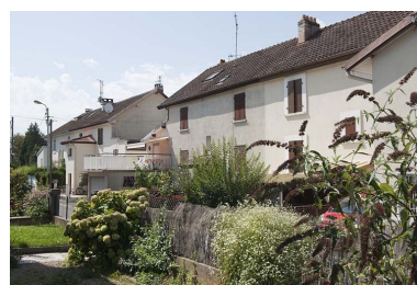
Façades postérieures vues de trois quarts. Phot. Jérôme Mongreville IVR43_20112502084NUC4A
