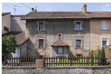
Façade antérieure vue de face. Phot. Jérôme Mongreville IVR43_20112502081NUC4A
