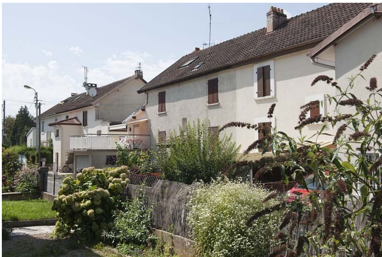
Façades postérieures vues de trois quarts.
