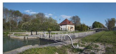
Vue d'amont. Phot. Thierry Kuntz IVR26_20112102602NUC4A
