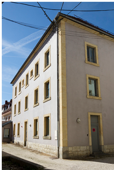
Façade postérieure, vue en enfilade.
