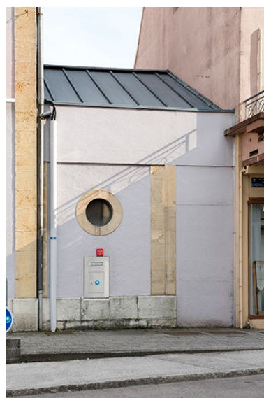
Façade antérieure : vestige de l'atelier de fabrication. Phot. Sonia Dourlot IVR43_20182500704NUC4A
