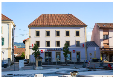
Façade antérieure (2013). Phot. Yves Sancey IVR43_20132502266NUC2A
