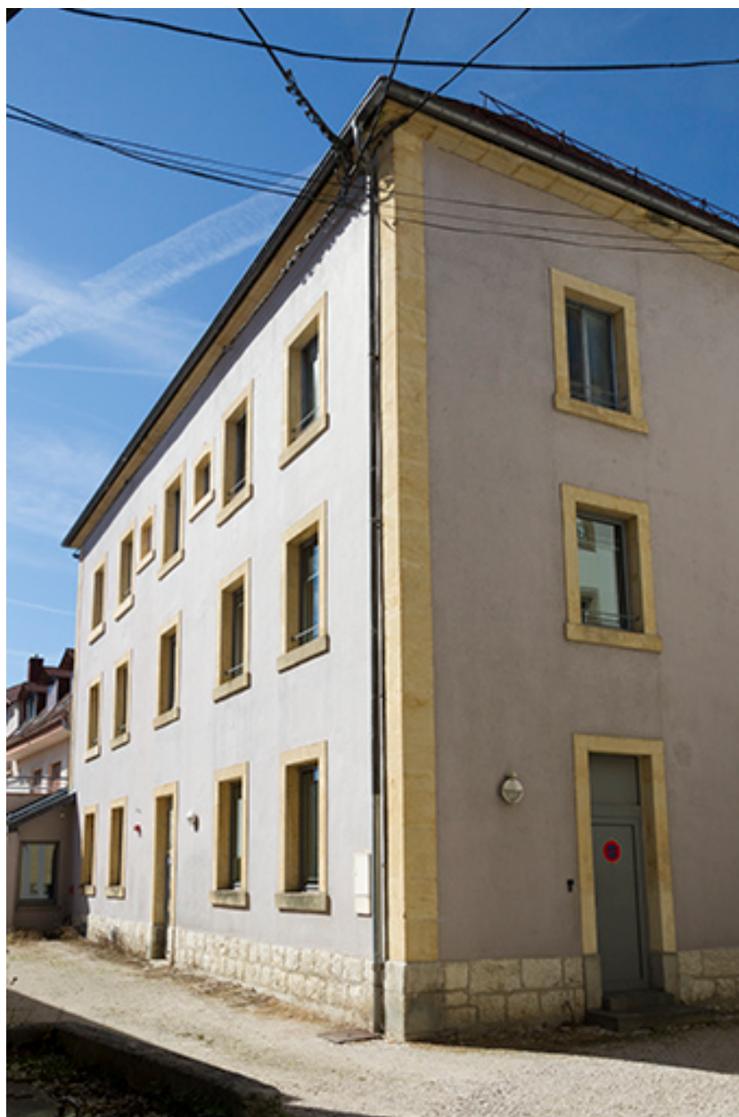
Façade postérieure, vue en enfilade.
