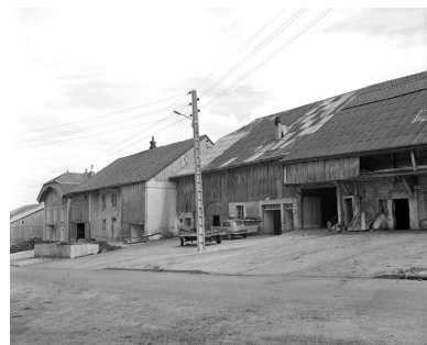
Centre du village : constructions opposées à la chapelle reconstruites après l'incendie (vers 1840). Phot. Yves Sancey IVR43_19782500520X
