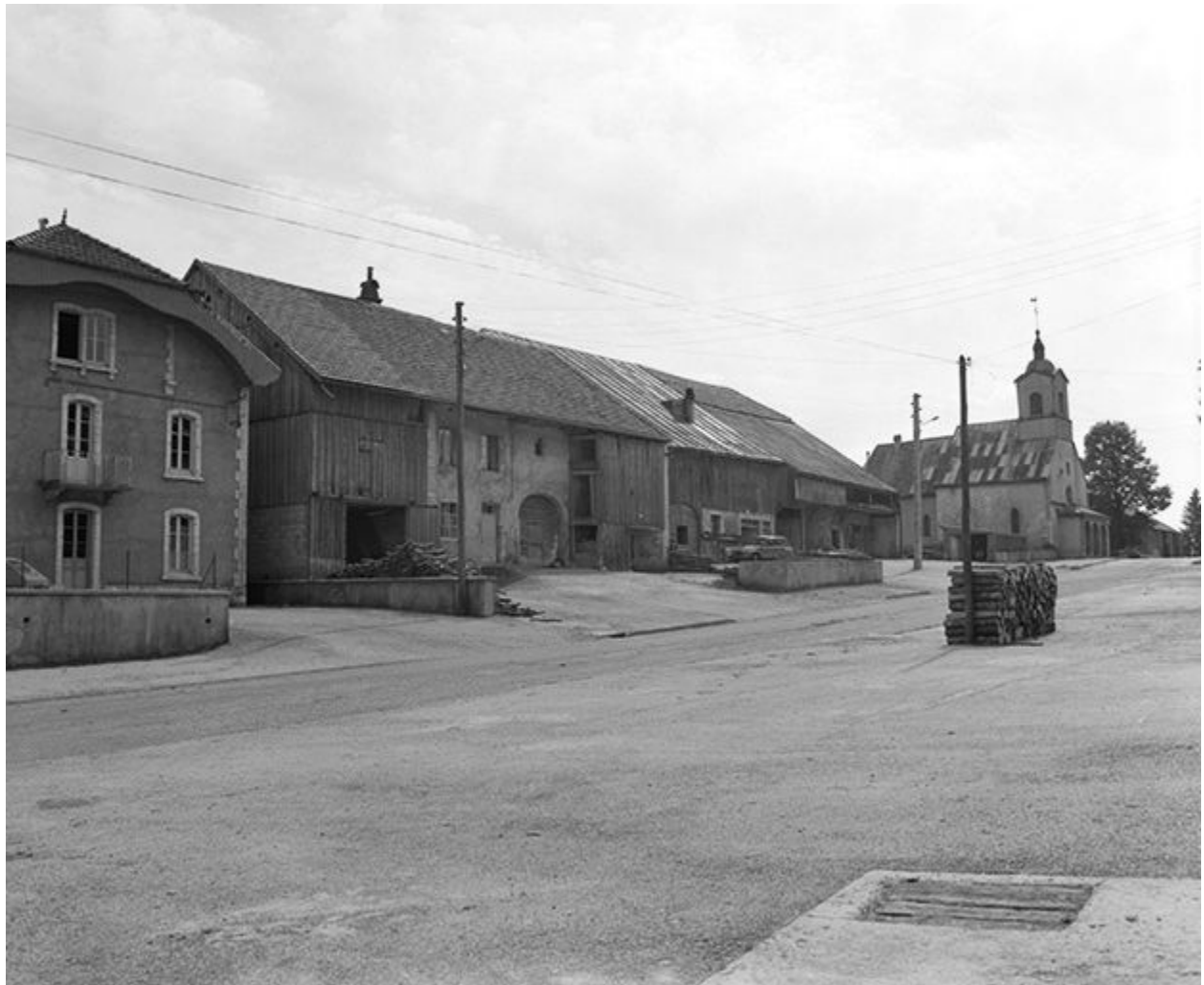
Centre-ouest du village, du côté de la chapelle.
