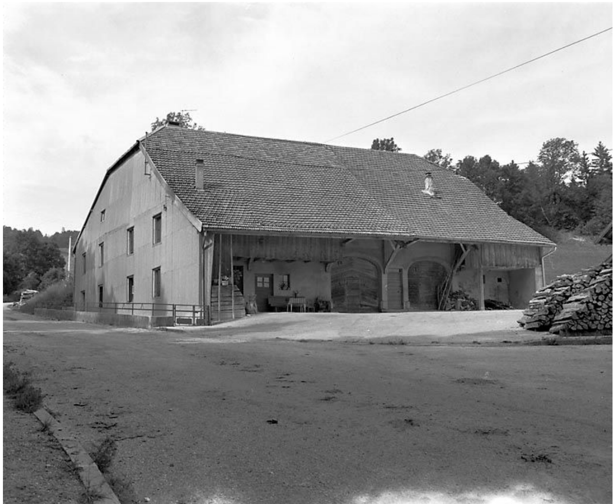
Ferme située chemin des Esseux.
