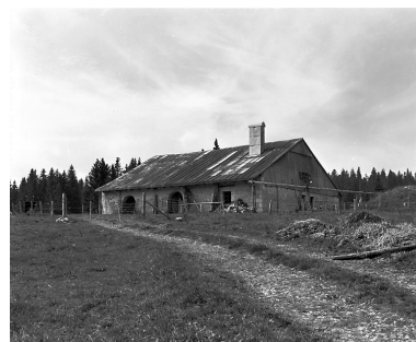
Ferme située au lieudit Le Pré Loin. Phot. Yves Sancey IVR43_19782500534X
