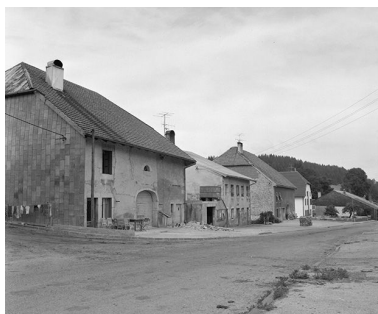
Centre du village : constructions opposées à la chapelle reconstruites après l'incendie (vers 1840). Phot. Yves Sancey IVR43_19782500519X
