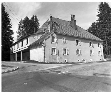
Ferme située Grande Rue. Phot. Yves Sancey IVR43_19782500521X
