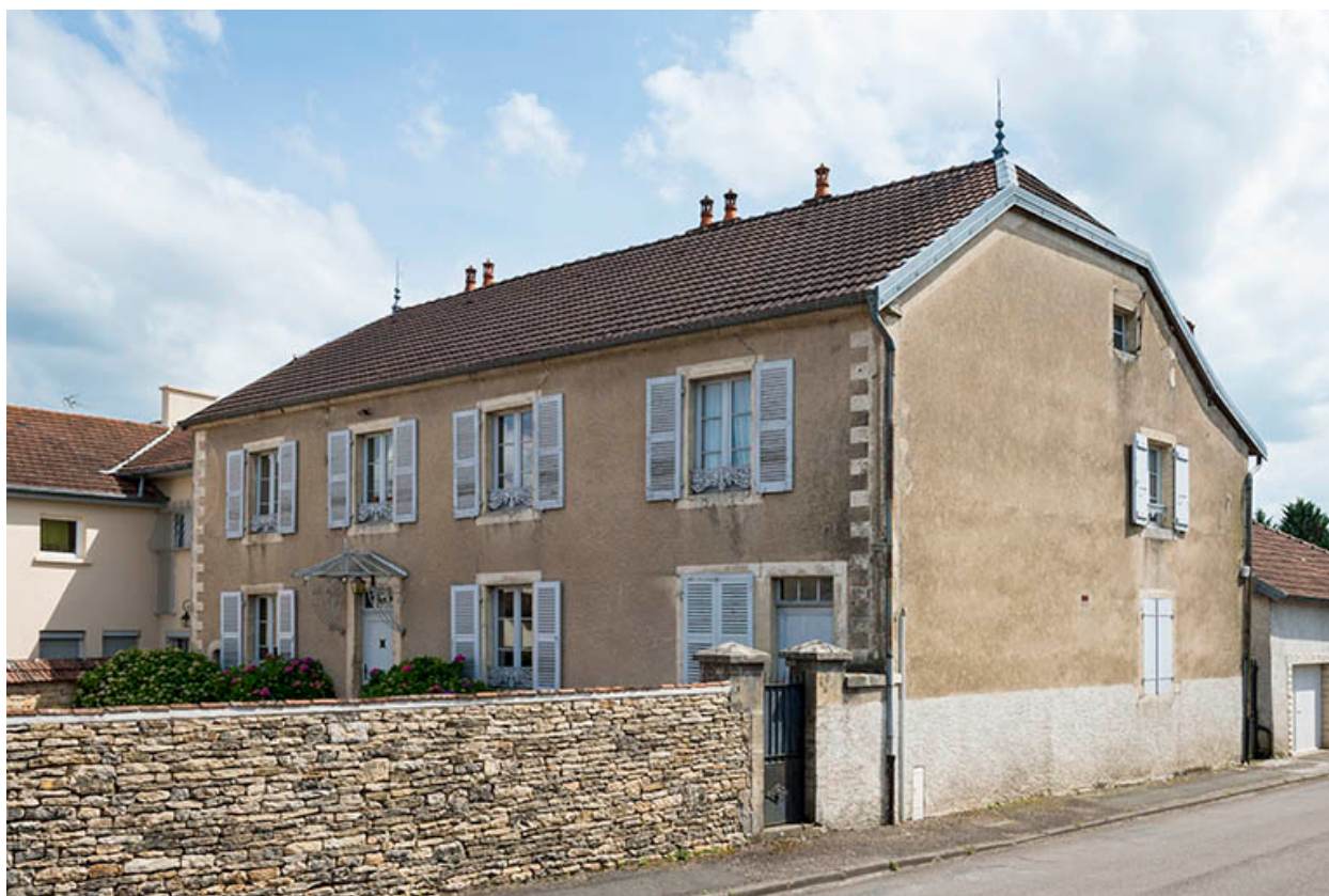
Façade principale, vue de trois quarts.
