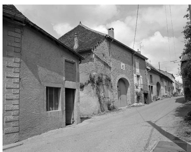
Ferme située rue Chateraine. Phot. Yves Sancey IVR43_19813900192X
