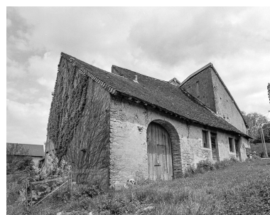
Ferme située rue Chateraine. Phot. Yves Sancey IVR43_19813900198X
