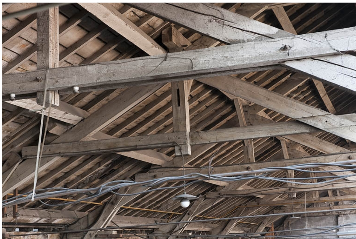
Détail de la charpente du magasin industriel.
