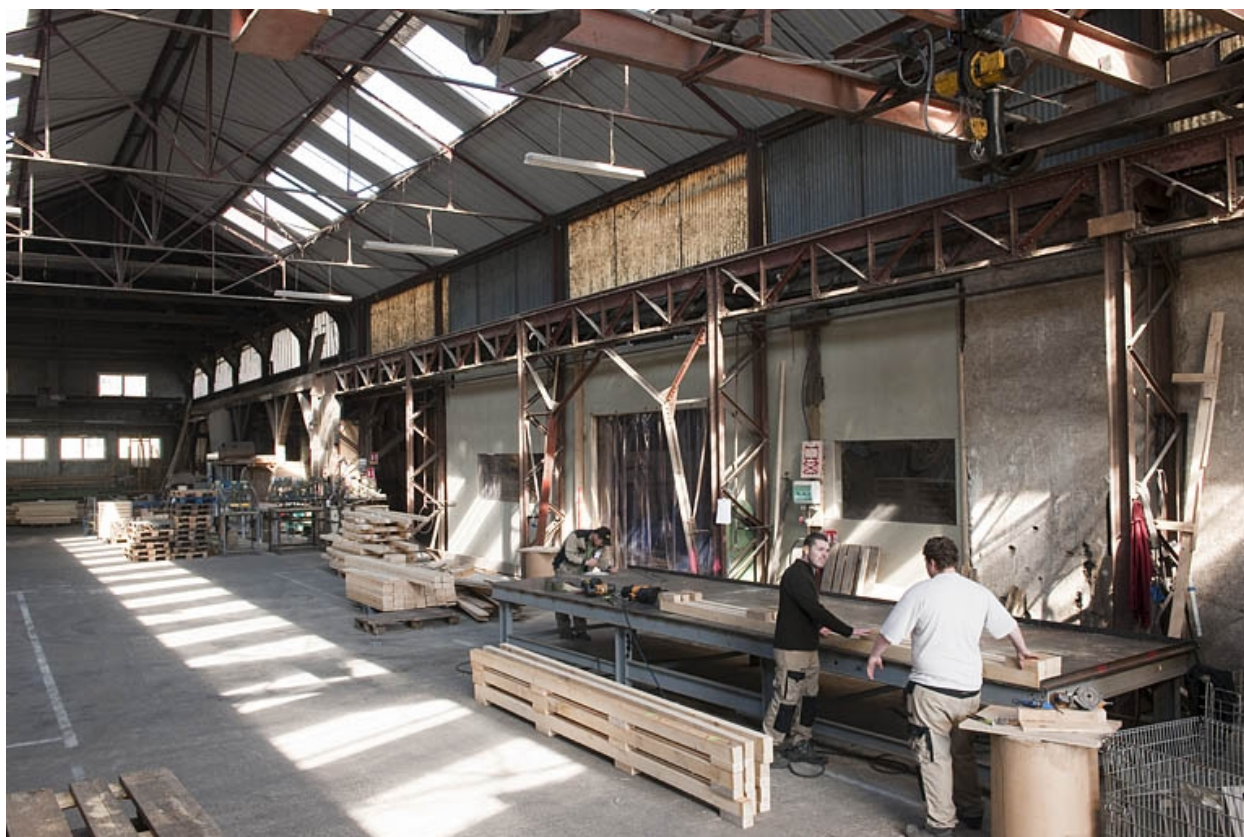
Halle de fonderie. Vue d'ensemble.
