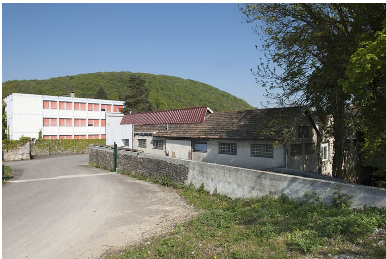
Bâtiment de bureaux et ancien atelier d'émaillage.
