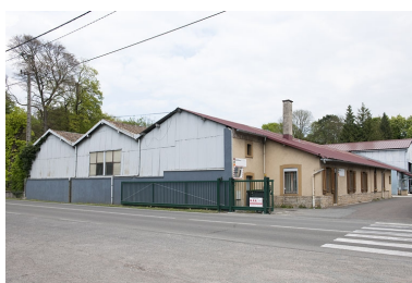
Entrée du site. Les magasins industriels. Phot. Jérôme Mongreville IVR43_20112501653NUC4A
