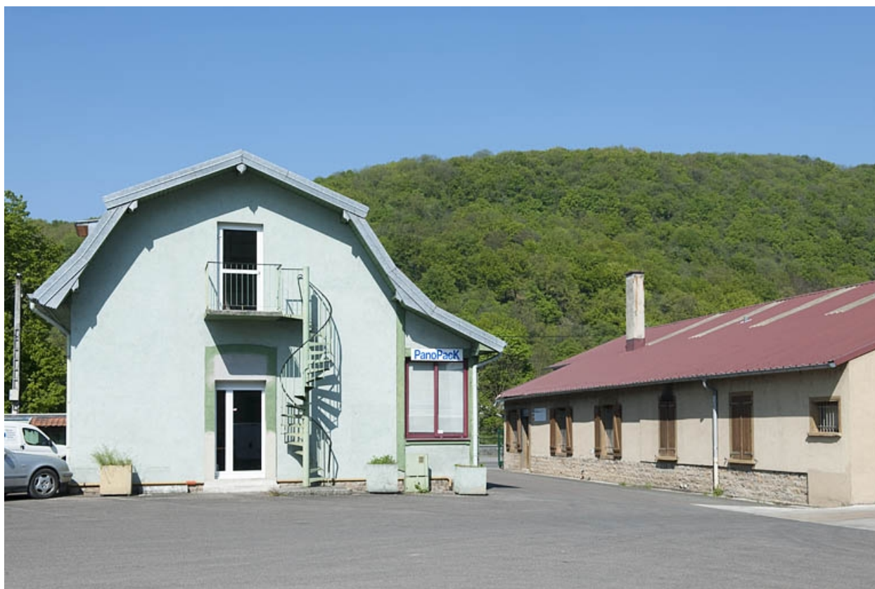
Bureaux et magasins industriels depuis l'est.
