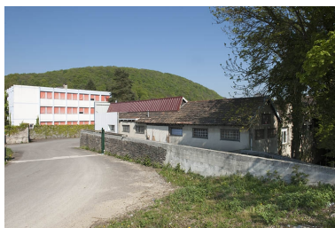
Bâtiment de bureaux et ancien atelier d'émaillage. Phot. Jérôme Mongreville IVR43_20112501643NUC4A
