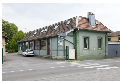
Entrée du site. Les bureaux. Phot. Jérôme Mongreville IVR43_20112501652NUC4A
