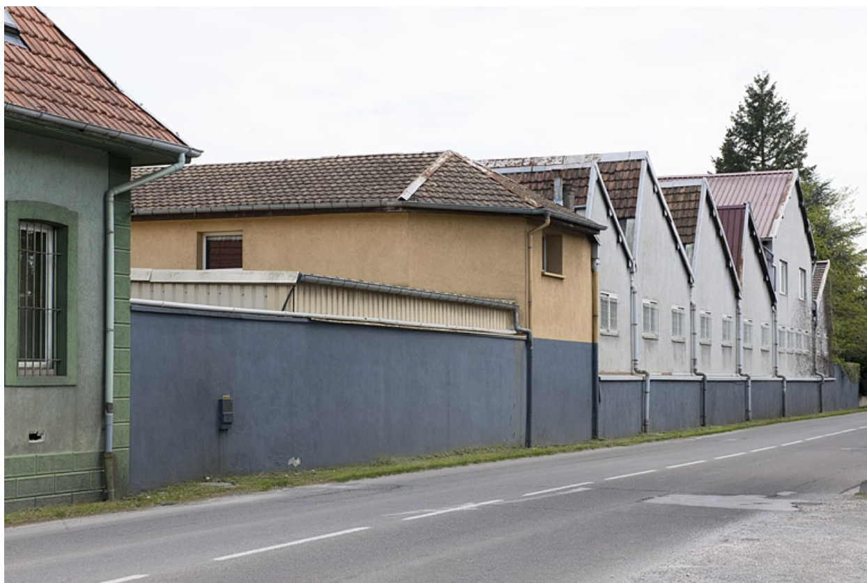
Façade sur rue de l'atelier de fabrication.
