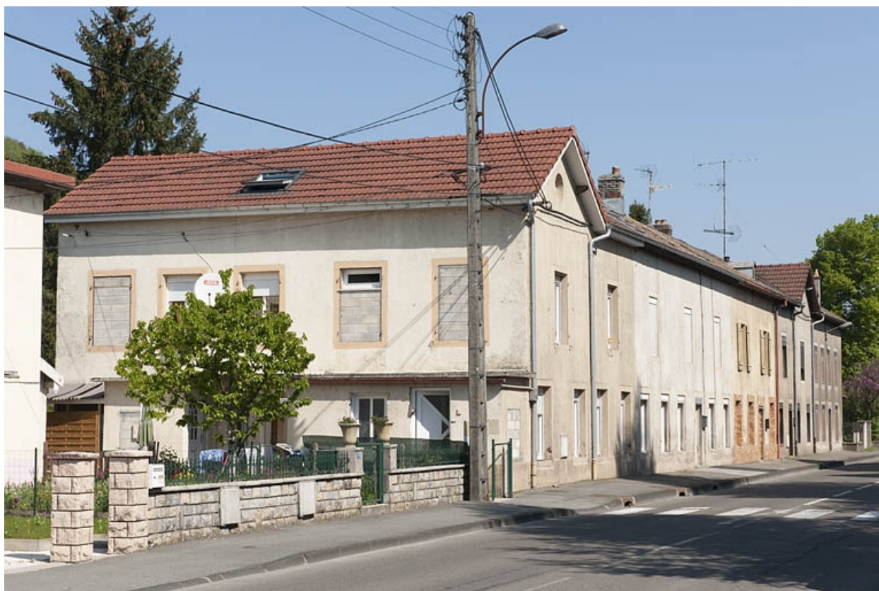
Logements ouvriers. Vue de trois quarts gauche.
