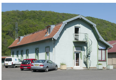
Bureaux. Vue depuis le sud-est. Phot. Jérôme Mongreville IVR43_20112501644NUC4A
