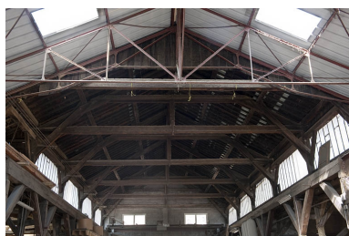
Halle de fonderie. La charpente. Phot. Jérôme Mongreville IVR43_20112501639NUC4A
