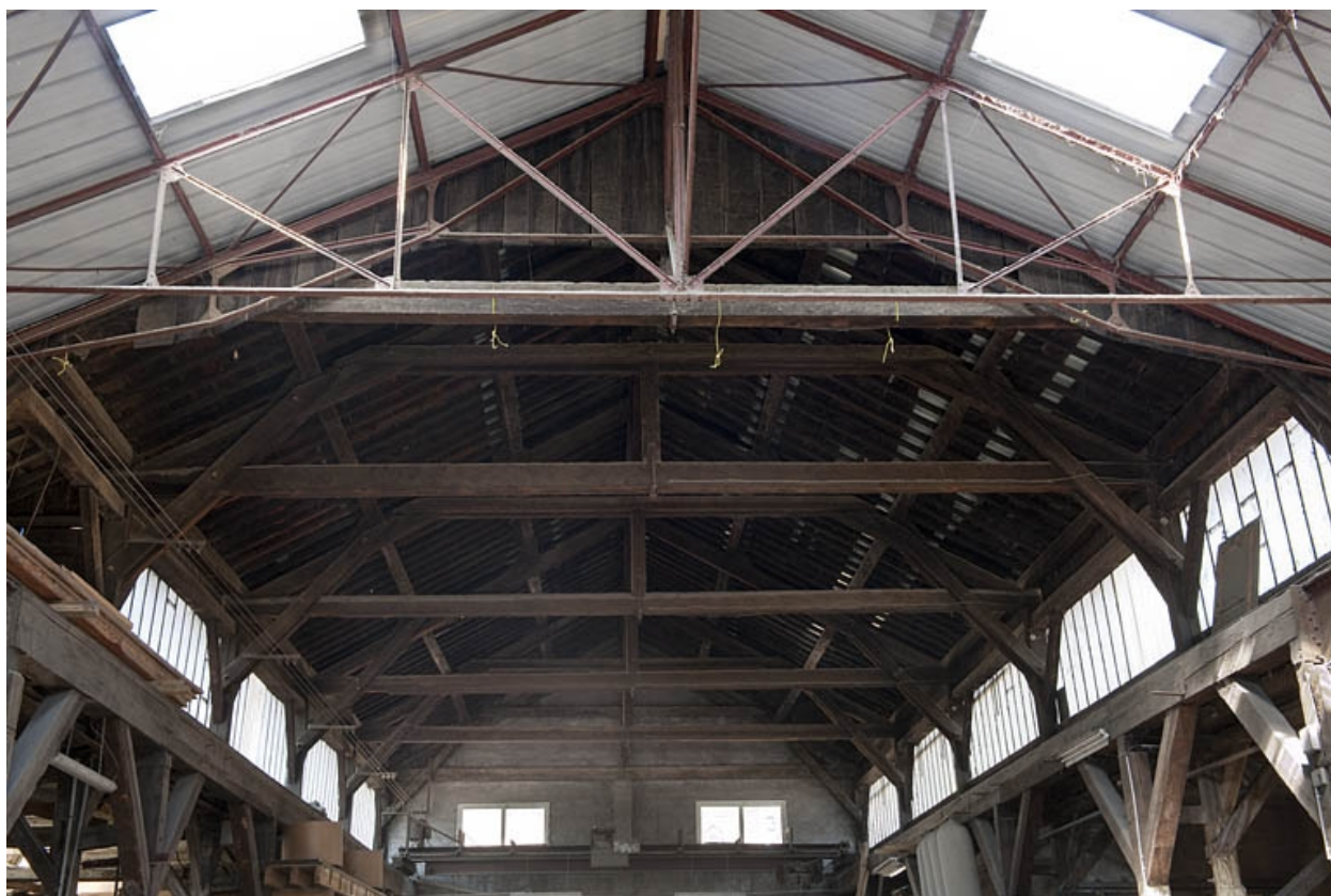
Halle de fonderie. La charpente.
