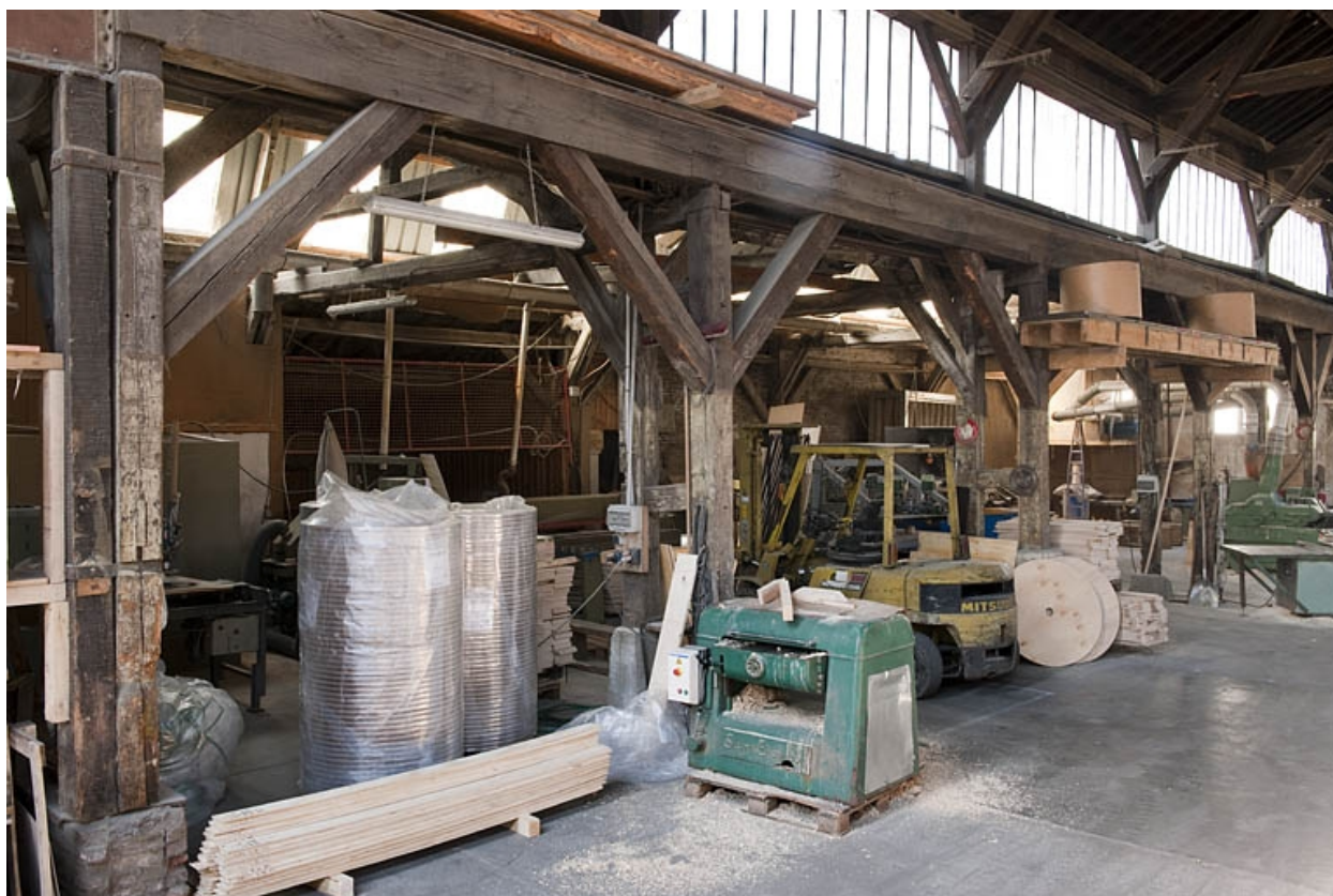
Halle de fonderie. Travée sud.
