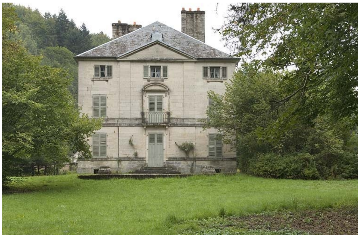
Façade sud de la demeure.
