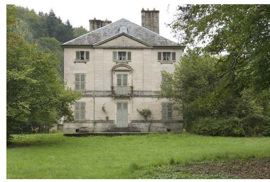
Façade sud de la demeure. Phot. Jérôme Mongreville IVR43_20067000698NUCA
