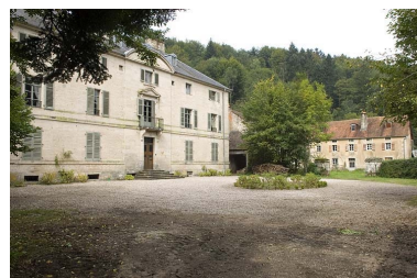
La demeure et la ferme depuis le sud. Phot. Jérôme Mongreville IVR43_20067000705NUCA
