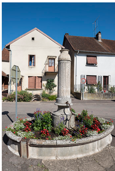
Vue d'ensemble. Phot. Jérôme Mongreville IVR43_20187000340NUC4A
