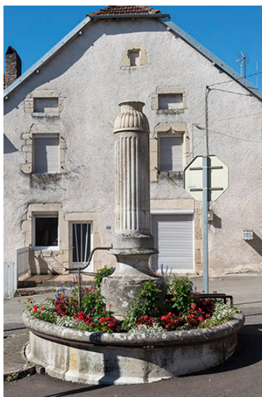
Vue d'ensemble. Phot. Jérôme Mongreville IVR43_20187000339NUC4A
