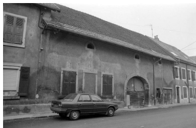
Vue de trois quarts gauche. Phot. Bernard Lardière IVR43_19832500156Z
