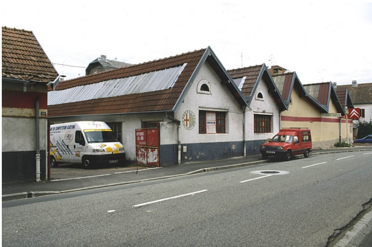
Pignons des ateliers depuis le nord-ouest.
