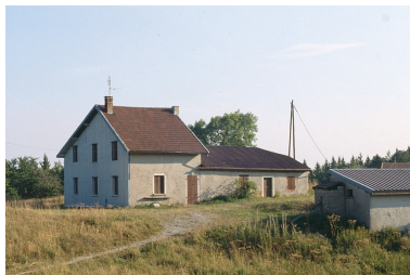
La fromagerie de Laisia. Phot. Laurent Poupard IVR43_19903900420ZA
