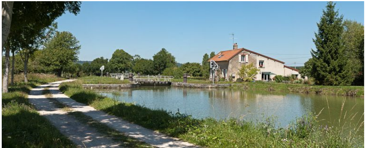
Vue d'ensemble du site d'écluse.
