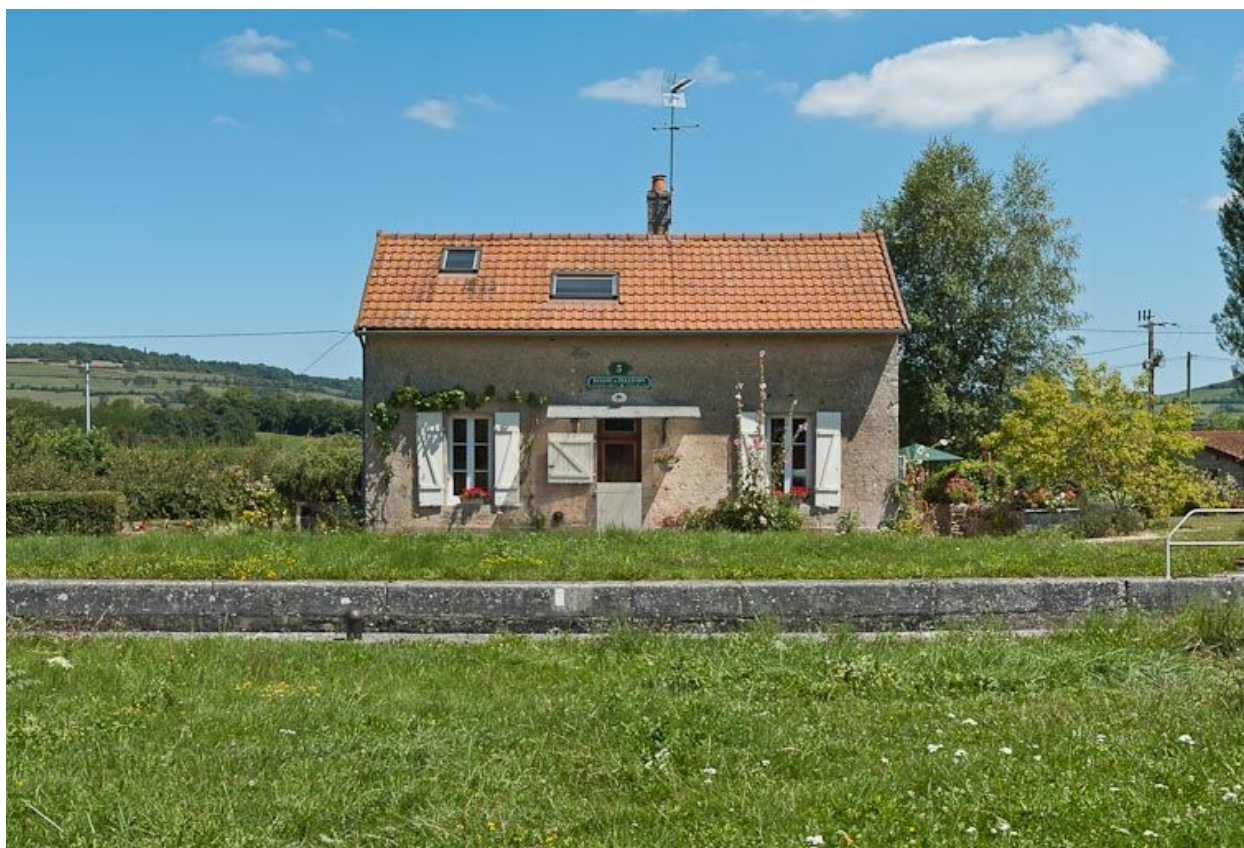
Vue de face de la maison éclusière.
