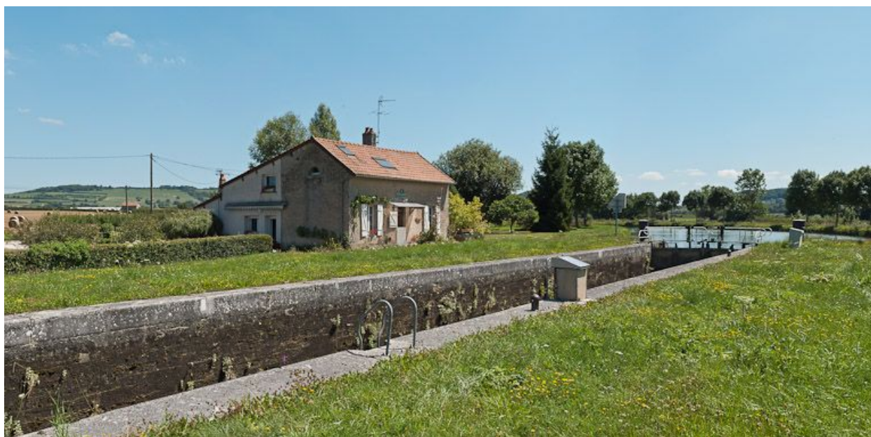
Vue d'ensemble du site d'écluse.
