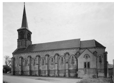
Vue de l'élévation droite. Phot. Michel Thierry IVR26_19782101165V
