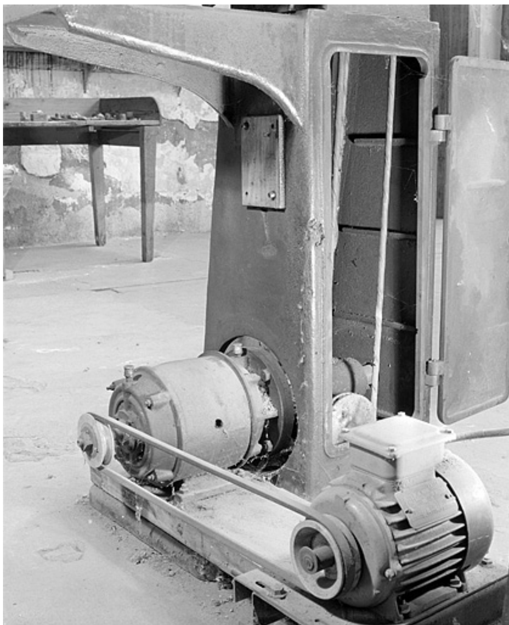
Vue des deux moteurs couplés.
