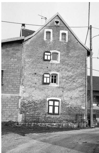
Façade latérale gauche. Phot. Bernard Lardière IVR43_19832500361Z
