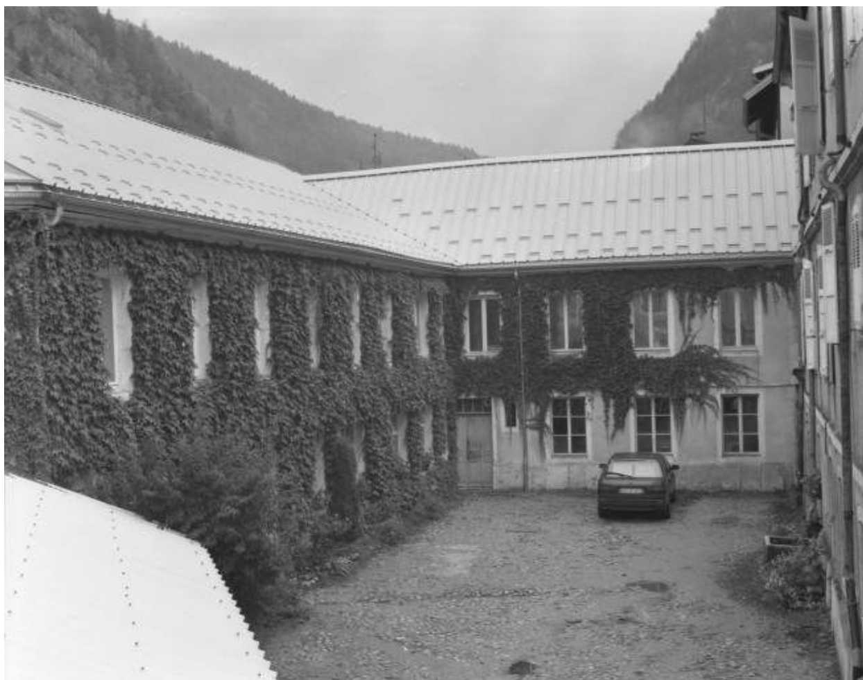
Façades de l'usine sur la cour.
