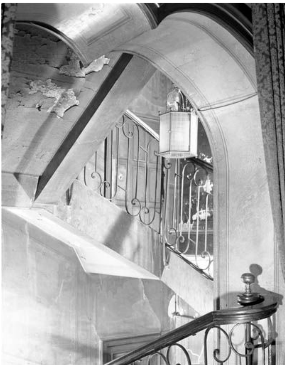
Logement patronal : cage d'escalier.
