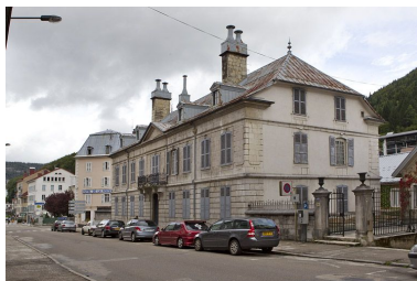
Façade du logement patronal, sur la rue.
