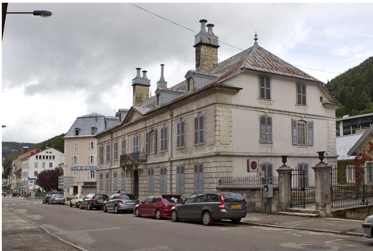
Façade du logement patronal, sur la rue.
