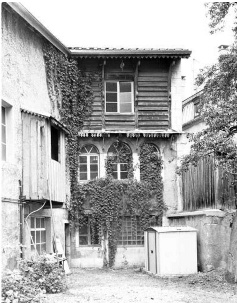
Atelier de fabrication (anciennes écuries et fenil).
