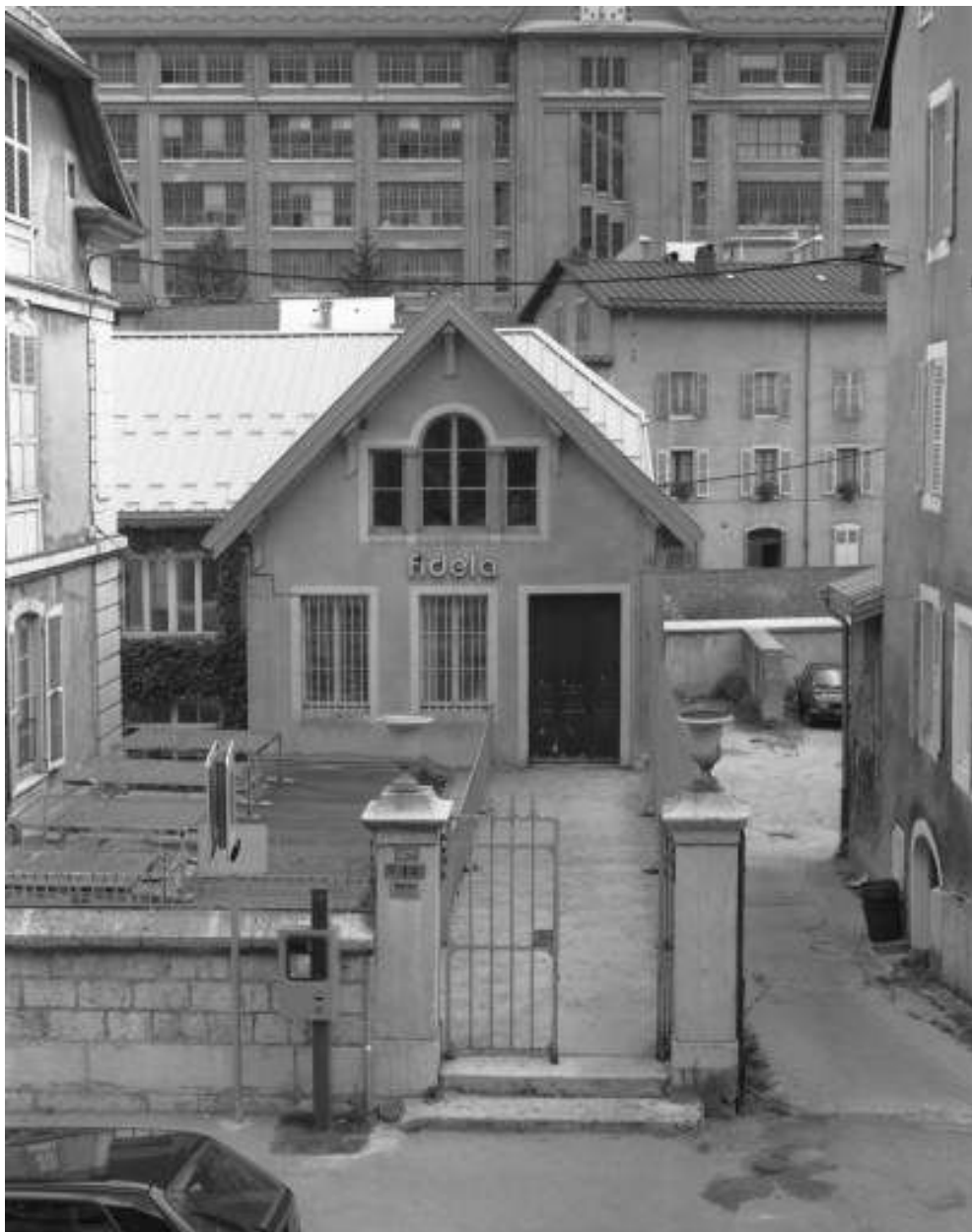
Façade antérieure de l'usine.
