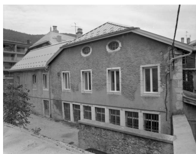
Façade latérale droite de l'usine. Phot. Jérôme Mongreville IVR43_19913900884X
