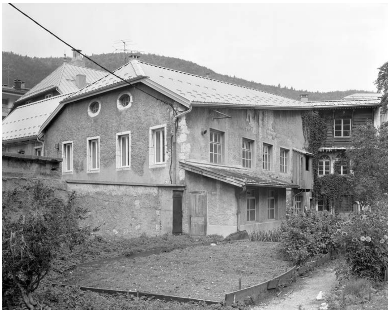
Façades latérale droite et postérieure de l'usine.
