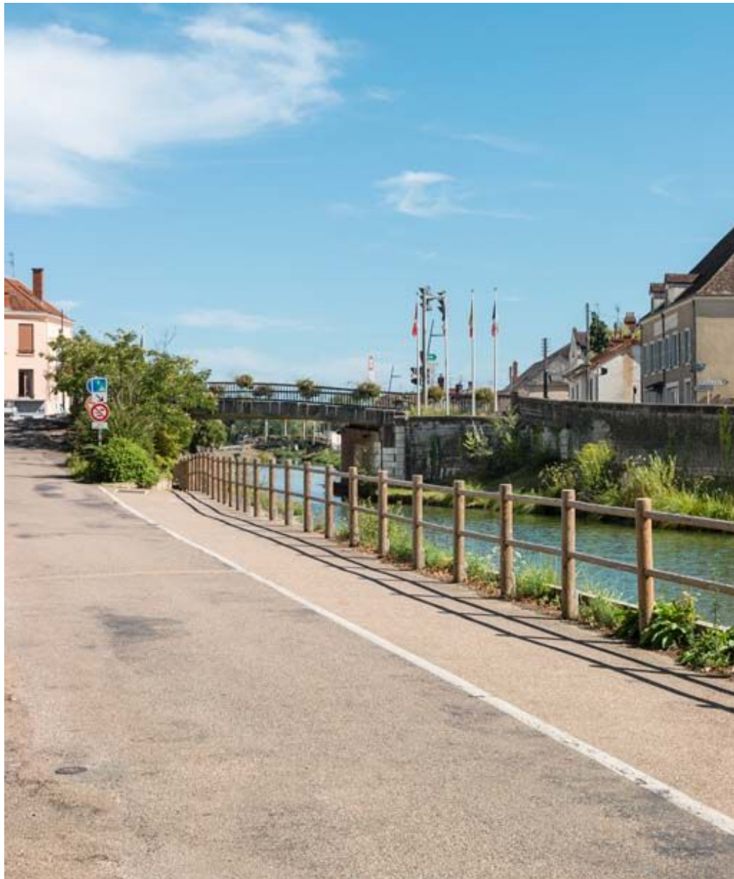
Vue d'ensemble du pont.
