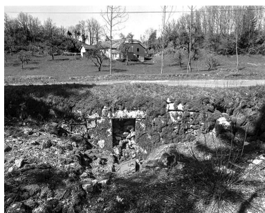
Citerne enterrée. Phot. Yves Sancey IVR43_19973900132X
