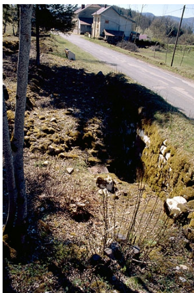
Citerne enterrée. Phot. Yves Sancey IVR43_19973900134ZA
