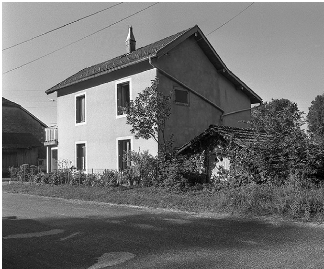
Logement de contremaître.
