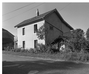
Logement de contremaître.
