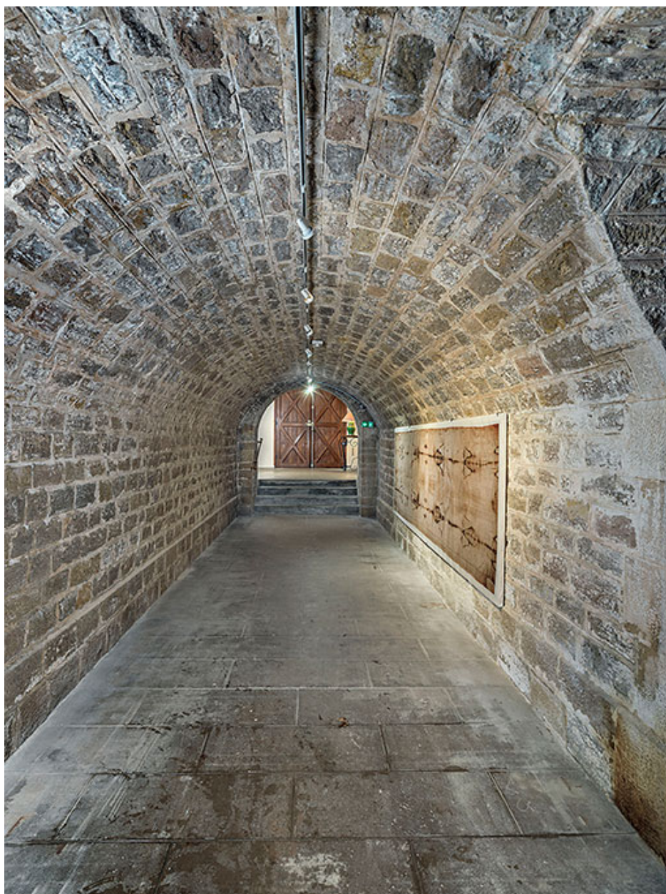
Galerie menant à la chambre de stockage.
