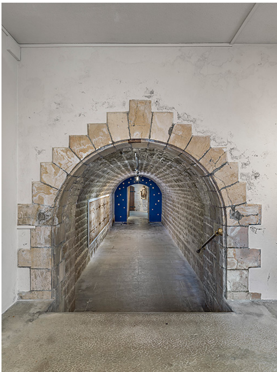
Porte d'entrée du magasin à poudre.
