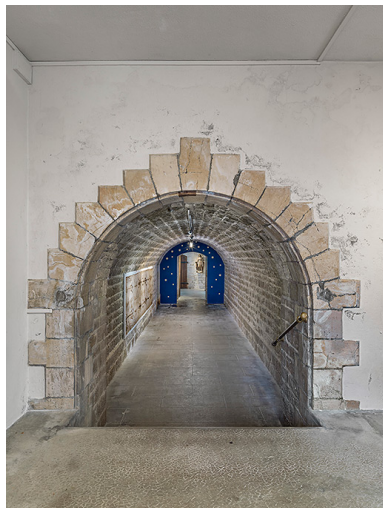
Porte d'entrée du magasin à poudre.
