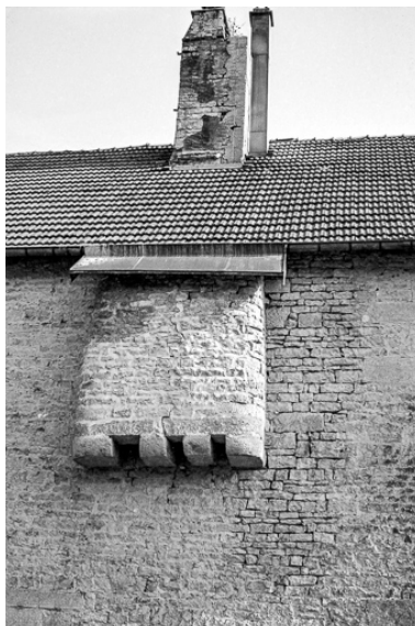
Façade postérieure : cul- du-four extérieur suspendu. Phot. Gilbert Poinot IVR43_19752501395Z
