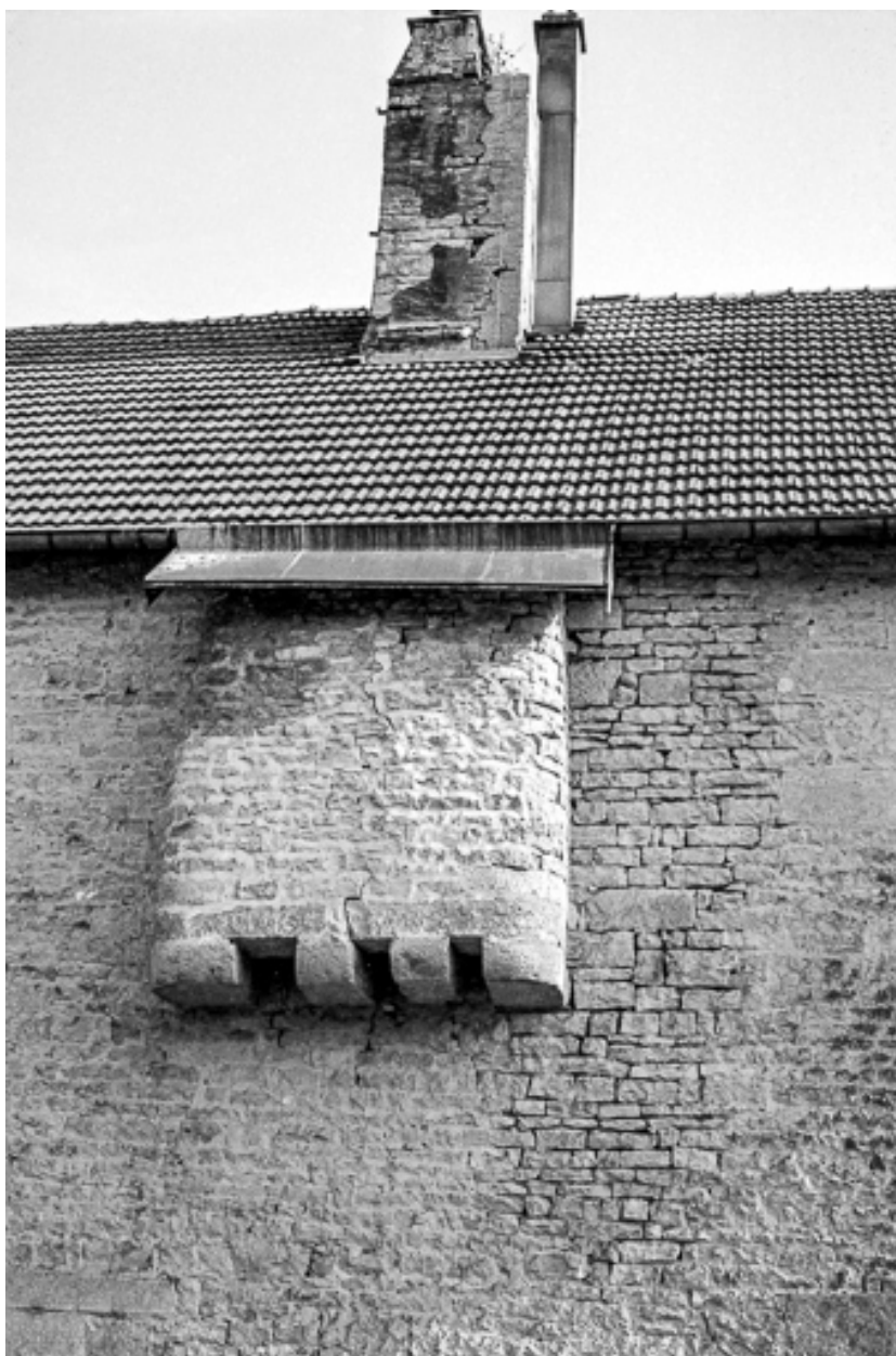
Façade postérieure : cul-du-four extérieur suspendu.
