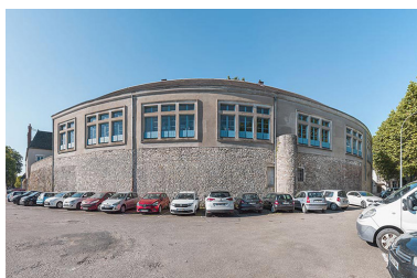
Vue générale. Phot. Thierry Kuntz IVR26_20247100031NUC4A
