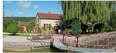
Vue du site d'écluse depuis l'amont. Phot. Pierre-Marie Barbe-Richaud IVR26_20112103943NUC4AQ
