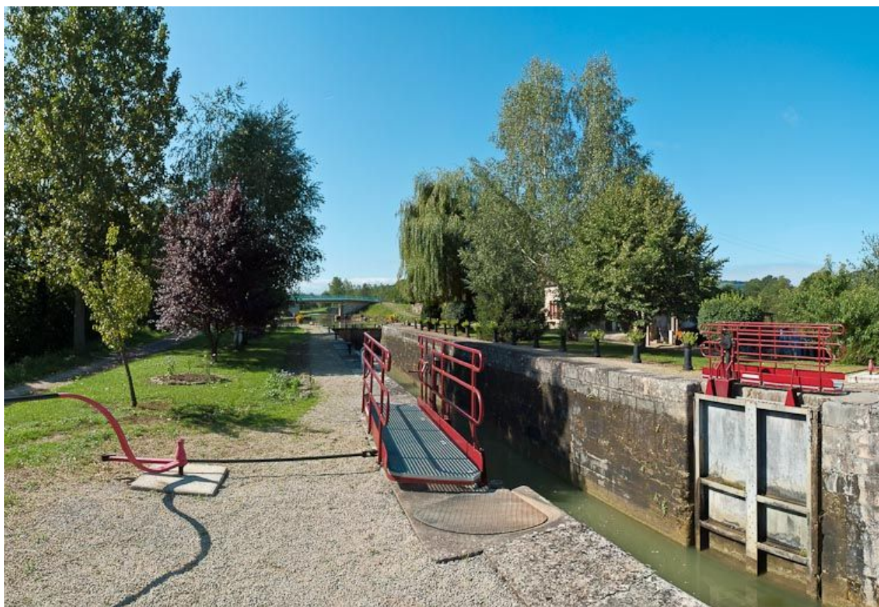
Vue du sas d'écluse.
