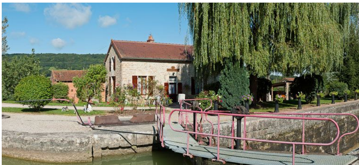
Vue du site d'écluse depuis l'amont.
