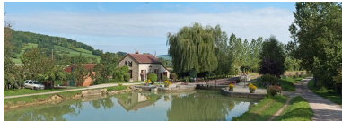
Vue du site d'écluse depuis l'amont. Phot. Pierre-Marie Barbe-Richaud IVR26_20112103940NUC4AQ
