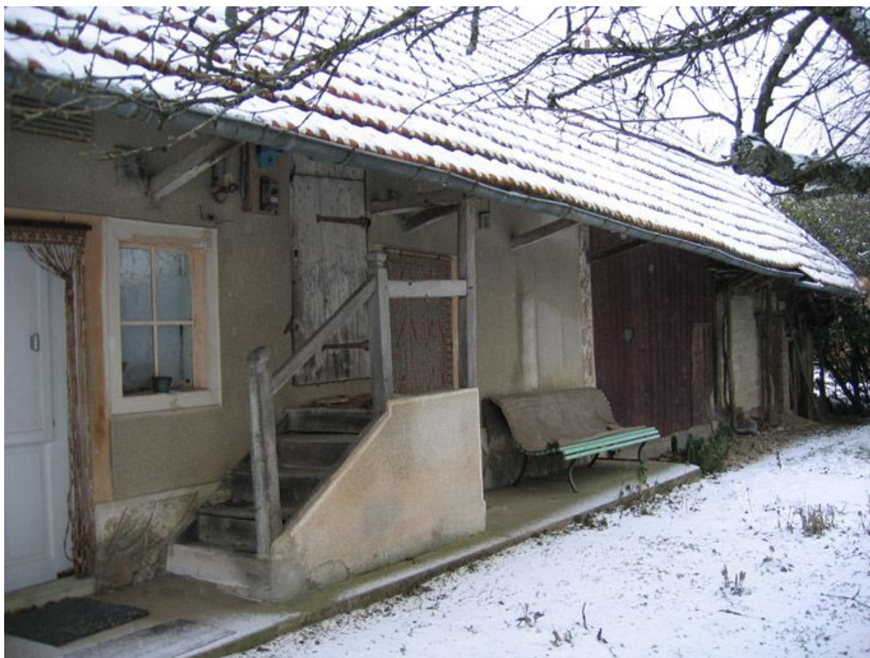
Vue d'ensemble de la façade.
