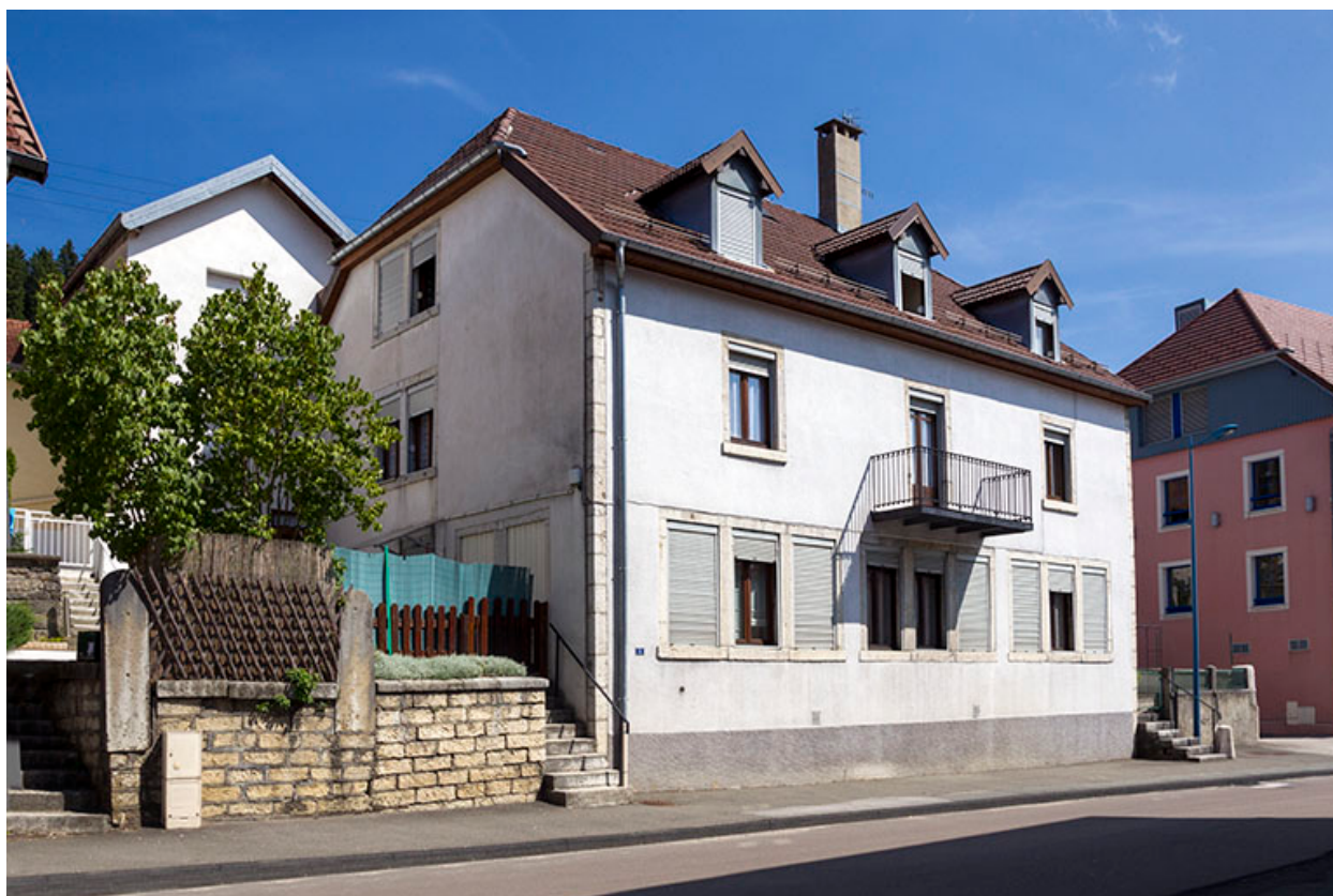
Façades antérieure et latérale gauche.
