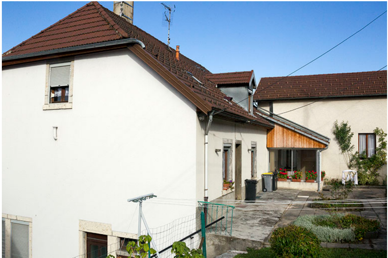
Façades postérieure et latérale droite.
