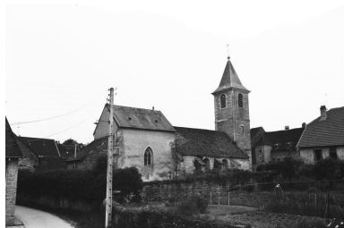
Vue latérale gauche. Phot. Guy Forestier IVR43_19743901022Z
