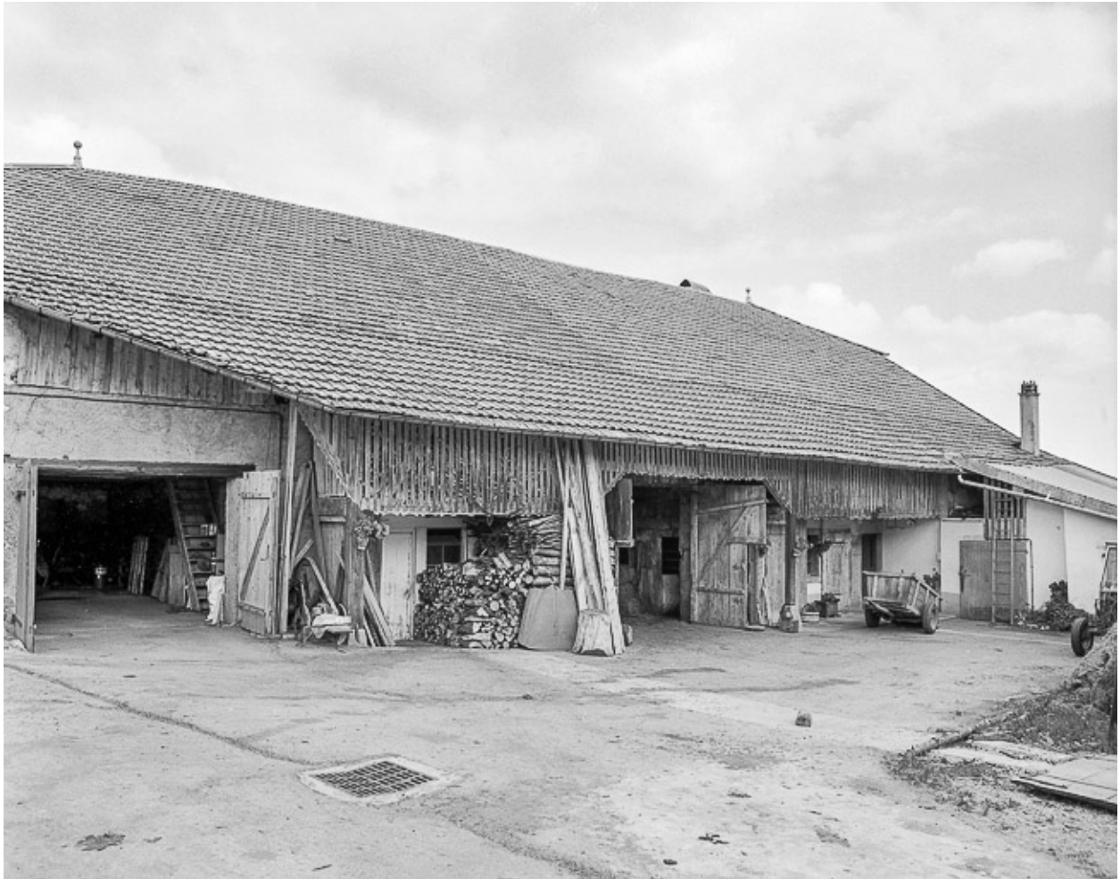
Mur goutterot d'une ferme.
