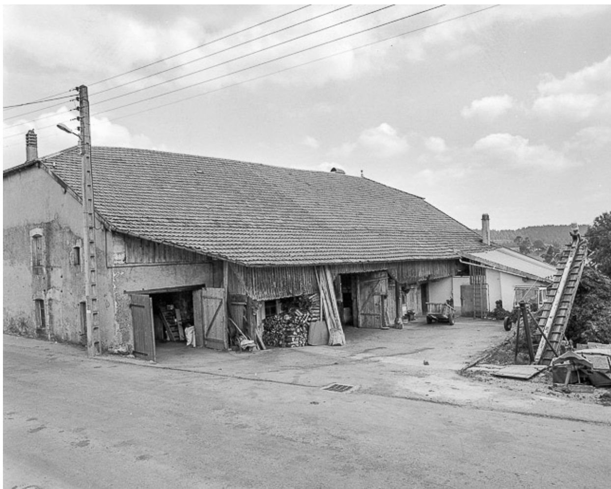
Mur goutterot d'une ferme.
