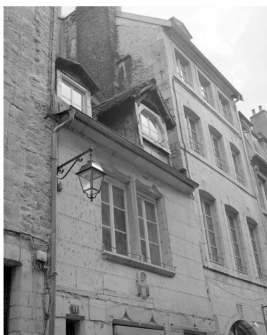
Façade sur rue : détail du premier étage.
