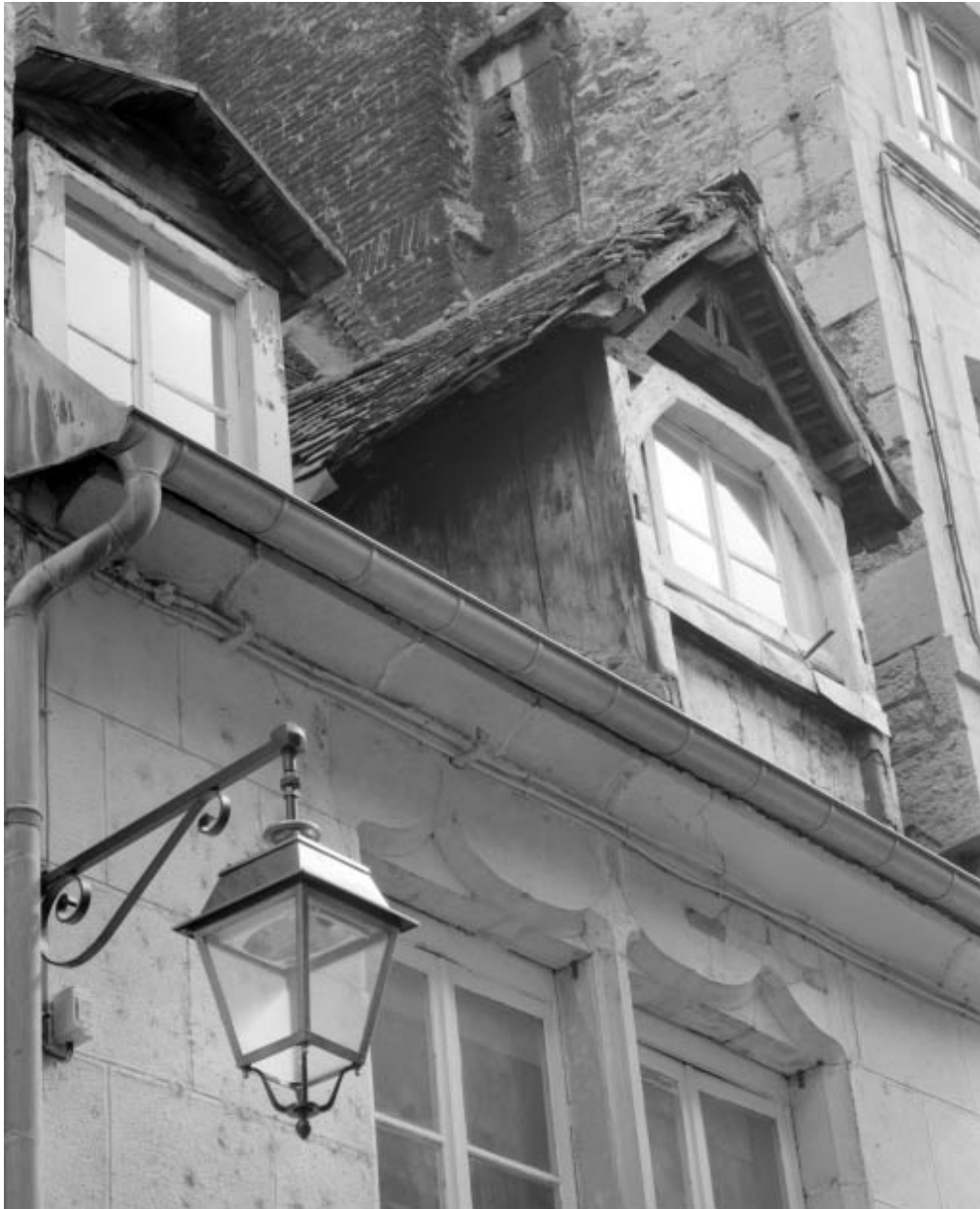
Façade sur rue : détail des lucarnes.
