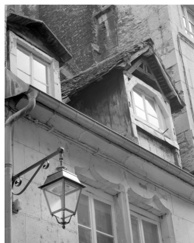
Façade sur rue : détail des lucarnes.
