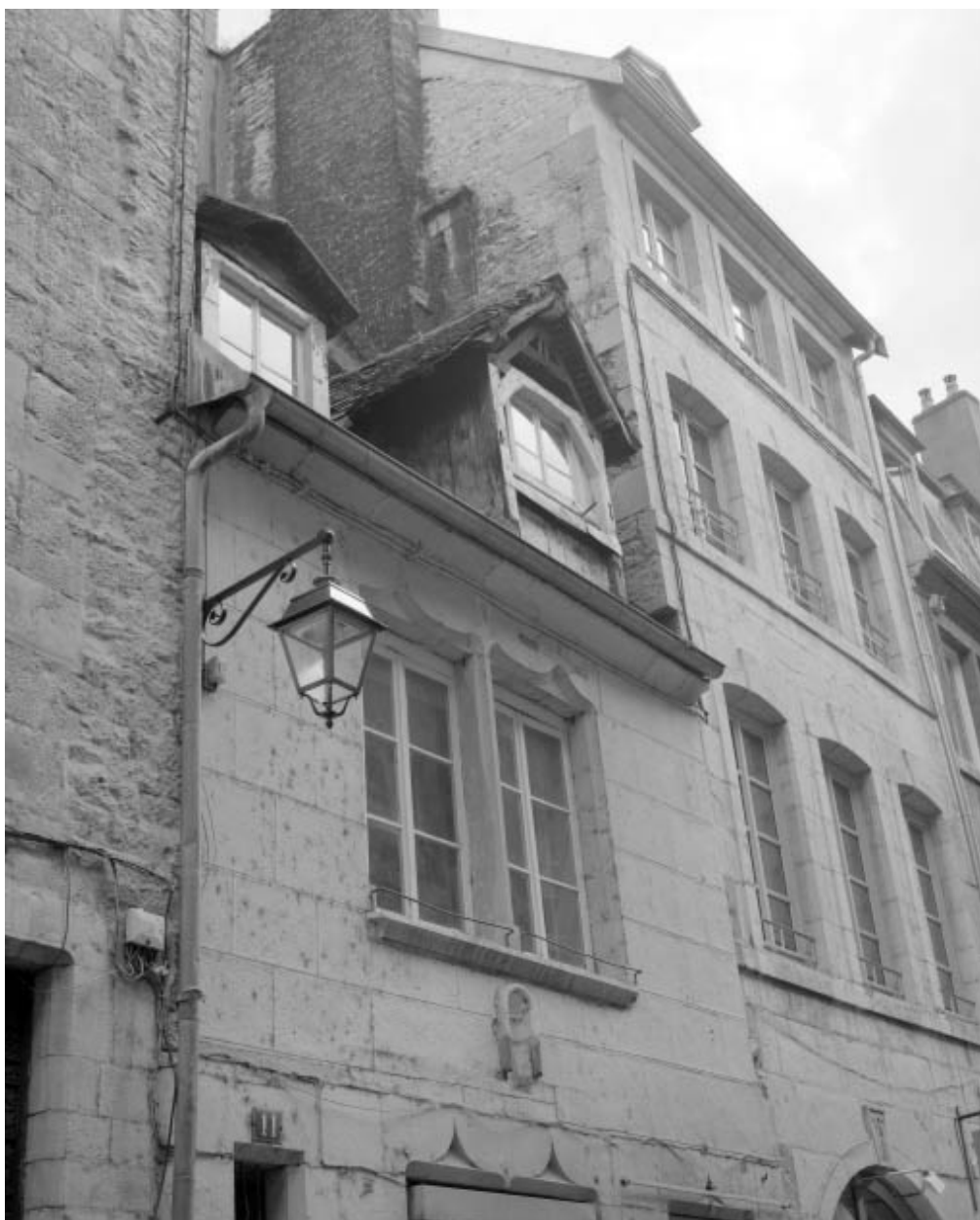
Façade sur rue : détail du premier étage.
