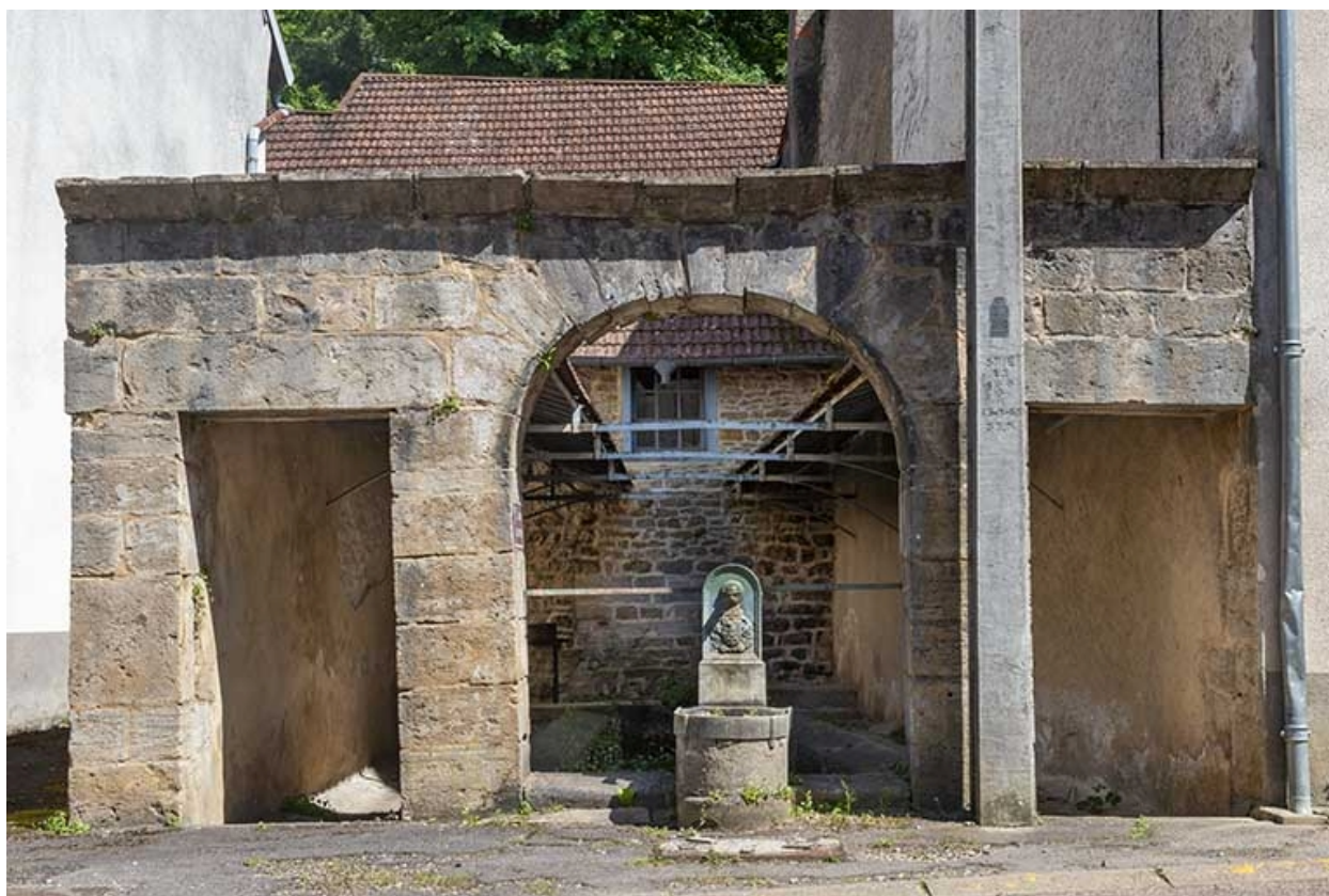
Face antérieure de la fontaine-lavoir.
