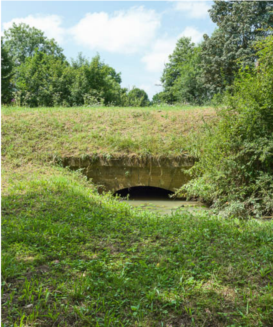
Vue de l'aqueduc.
