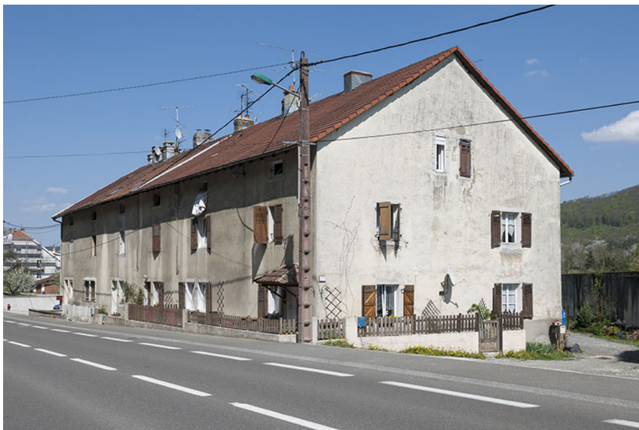
Logement d'ouvriers vu de trois quarts droite.
