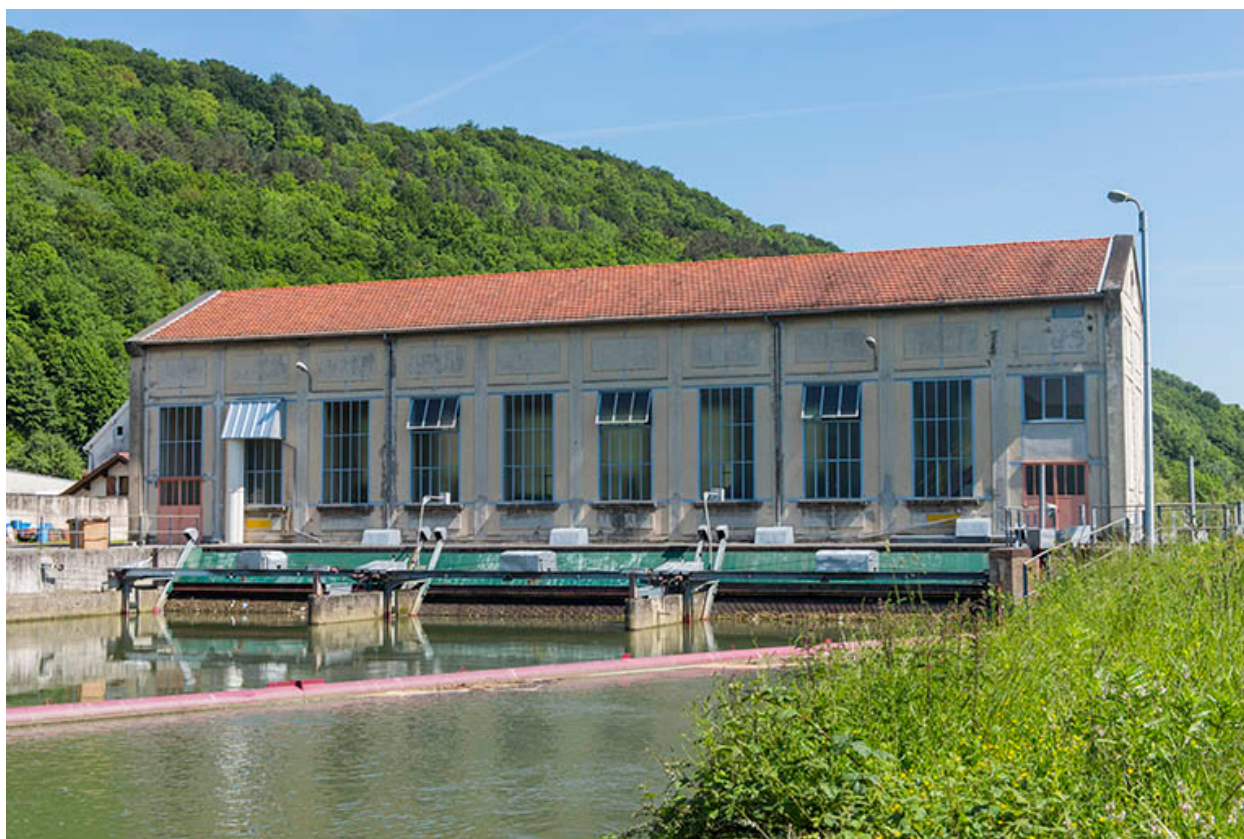
Bief d'amenée et centrale hydroélectrique.
