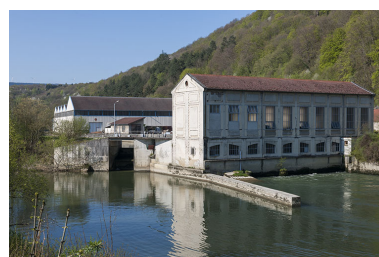
Vue d'ensemble du site depuis le nord-est.
