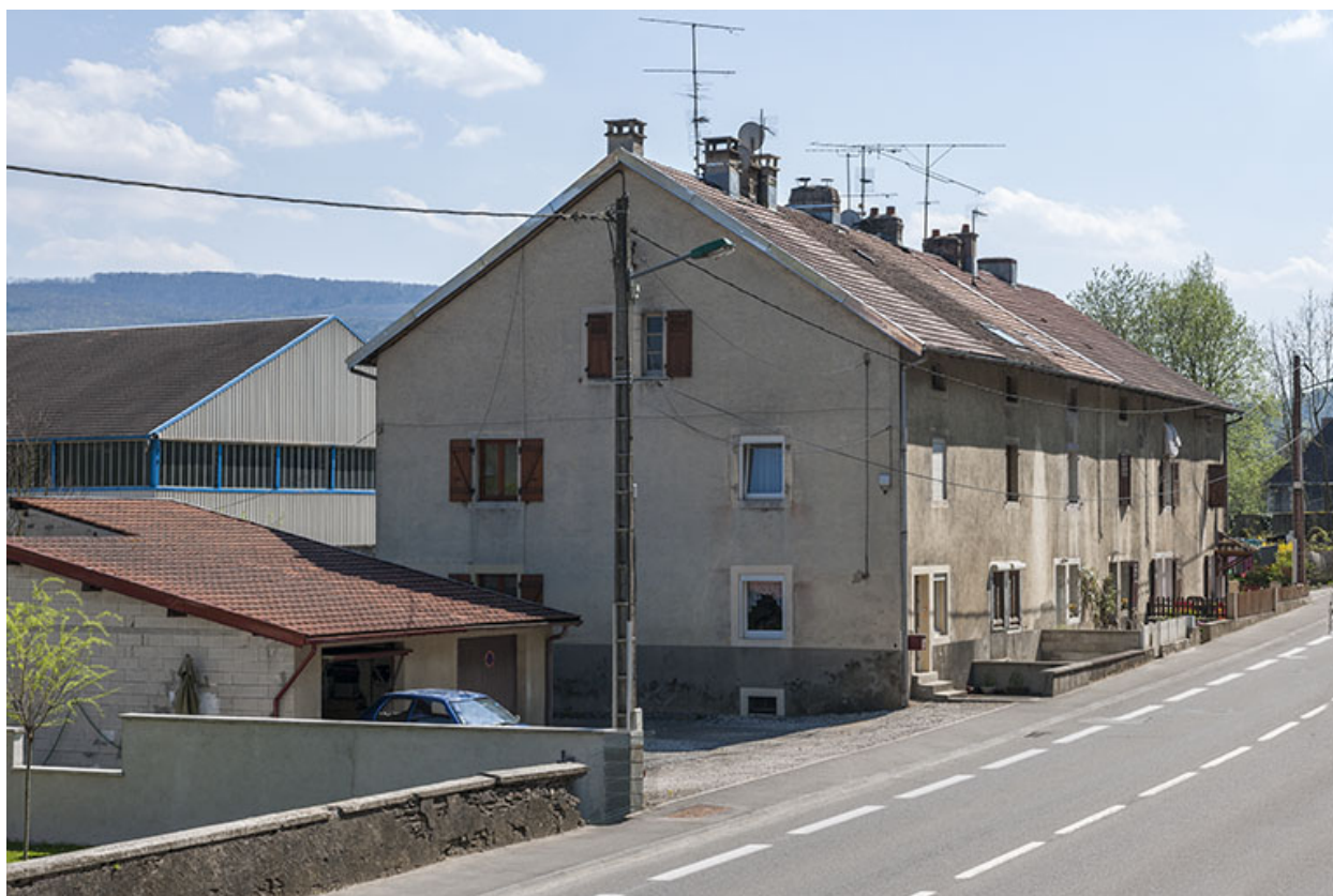
Logement d'ouvriers vu de trois quarts gauche.
