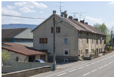
Logement d'ouvriers vu de trois quarts gauche. Phot. Mary Ruffinoni IVR43_20132500205NUC4A
