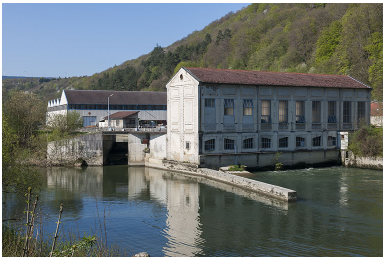
Vue d'ensemble du site depuis le nord-est.
