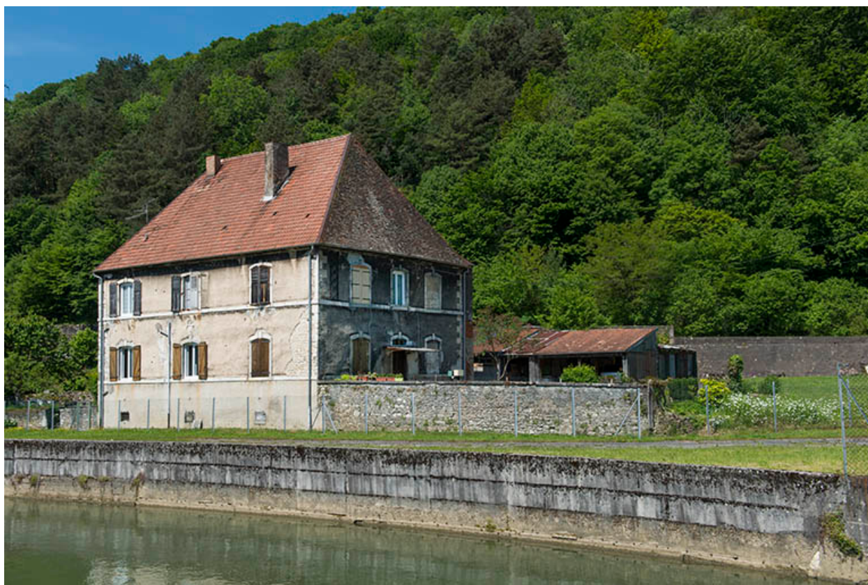
Bief d'amenée et logement patronal.
