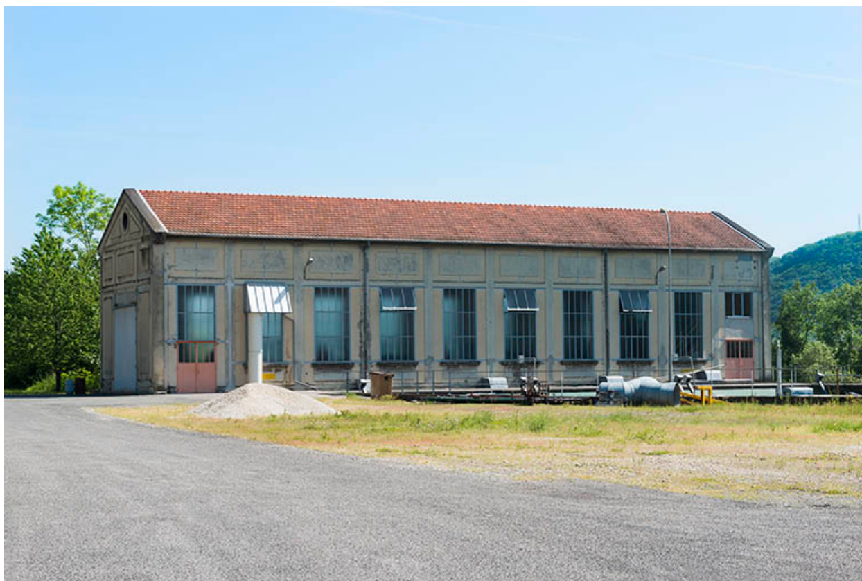
Façade sud de la centrale hydroélectrique.
