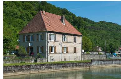
Logement patronal depuis le sud-est. Phot. Mary Ruffinoni IVR43_20132500618NUC4A
