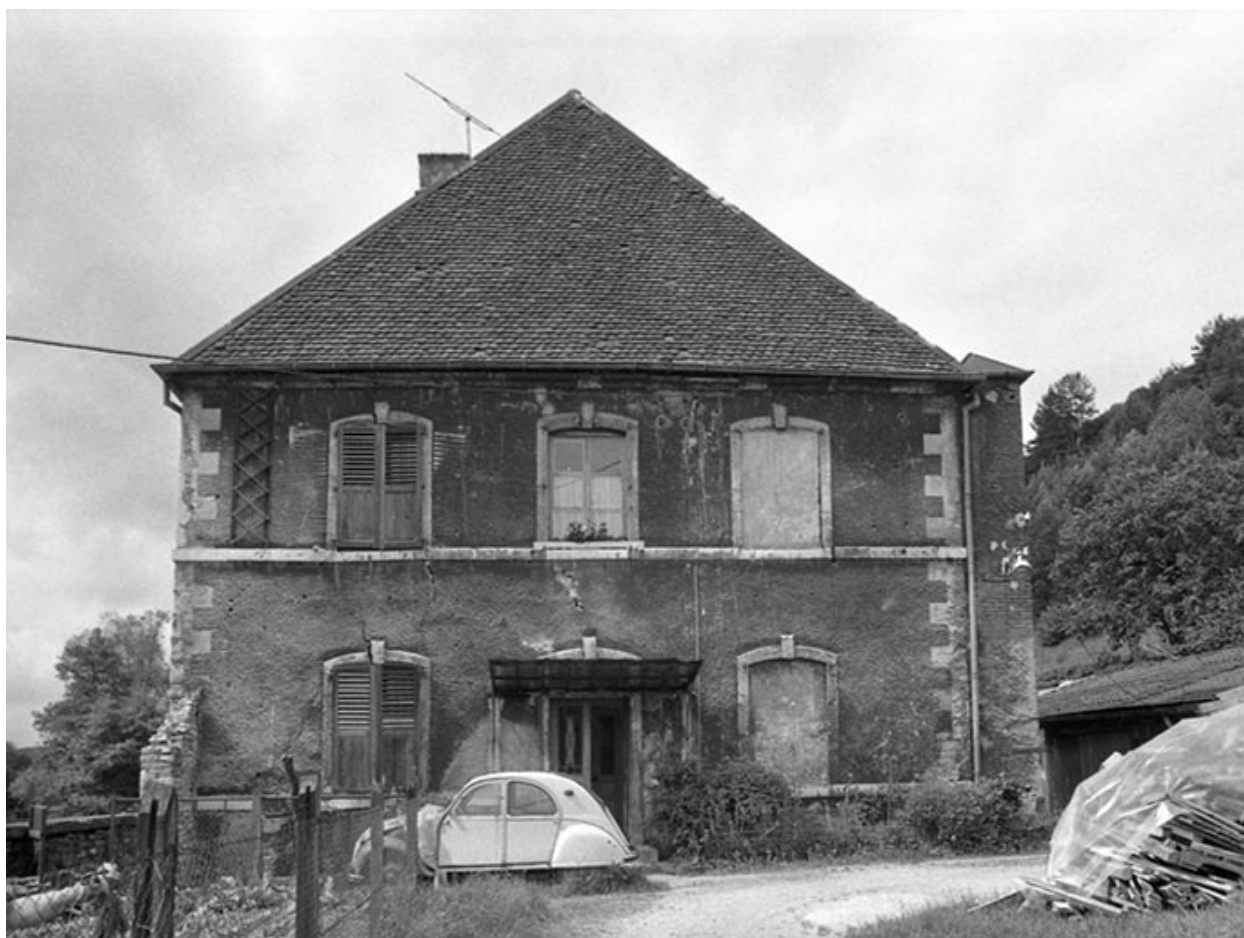
Façade nord du logement patronal en 1980.
