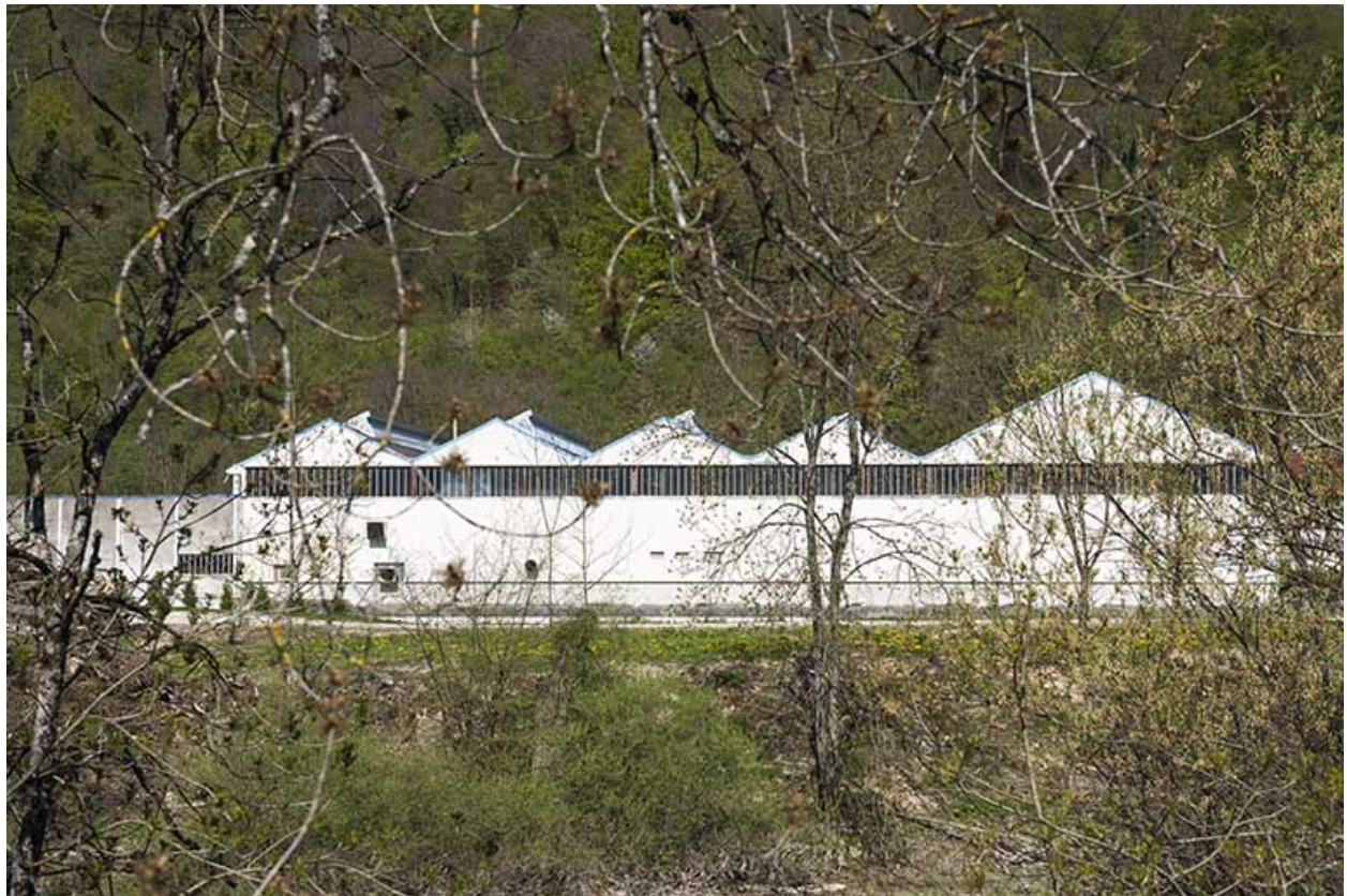
Façade est de l'atelier de laminage.
