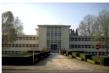
Façade antérieure, vue de face.
