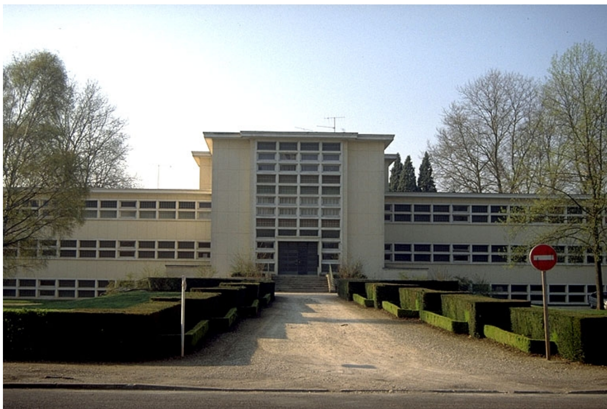
Façade antérieure, vue de face.
