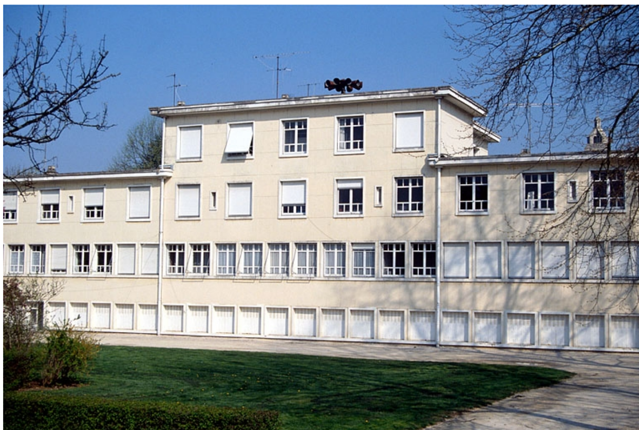
Façade postérieure, partie centrale.
