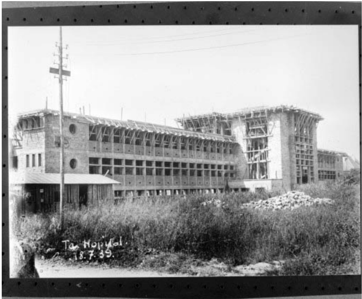
Travaux de construction de l'hôpital, façade antérieure.
