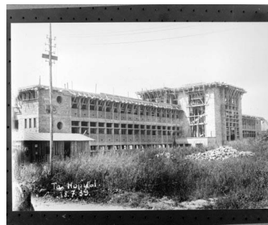
Travaux de construction de l'hôpital, façade antérieure.
