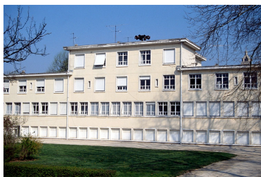
Façade postérieure, partie centrale.
